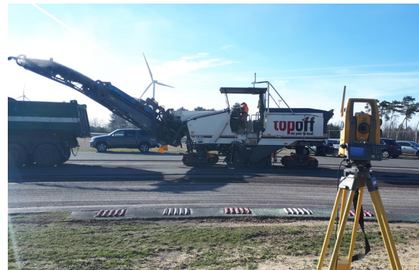
Fraisage sur le circuit piloté par station totale.
