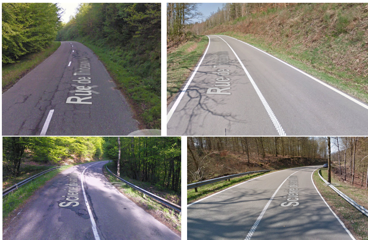
Situation avant (2009) et après (2019) travaux
