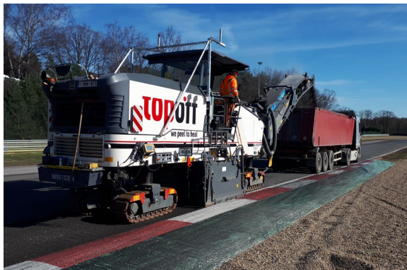
Fraisage sur le circuit piloté par station totale.
