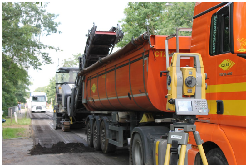
Fraisage piloté via une station totale
