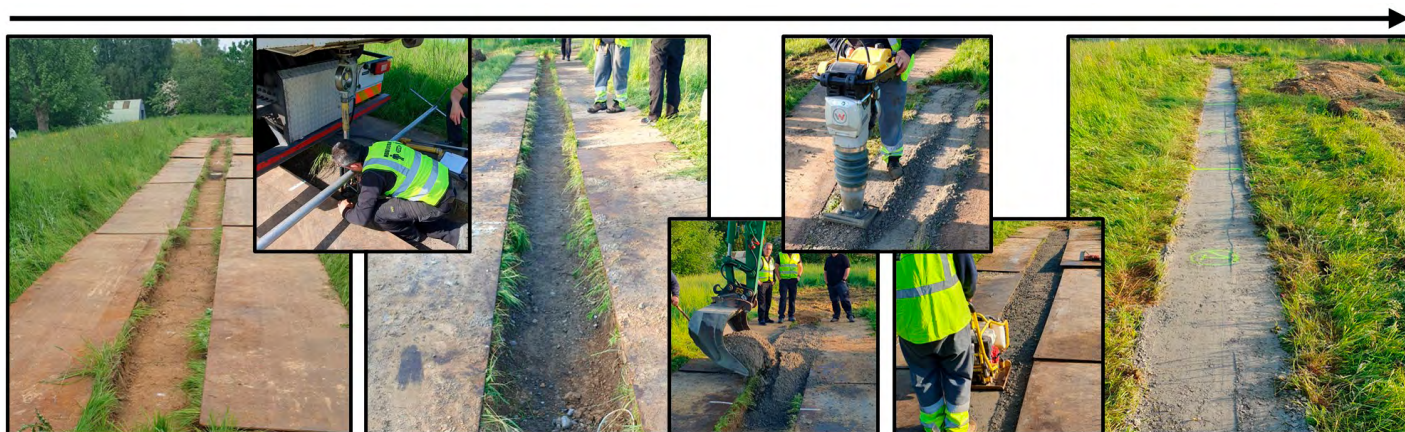
Figure 1 – Étapes de réalisation de la fondation en béton maigre sur le site de Sterrebeek. © CRR
