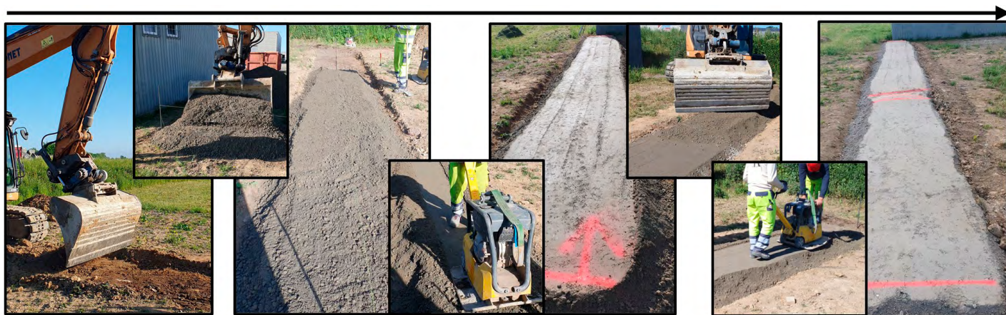
Figure 3 – Étapes de réalisation de la fondation en béton maigre sur le site de Fernelmont. © CRR
