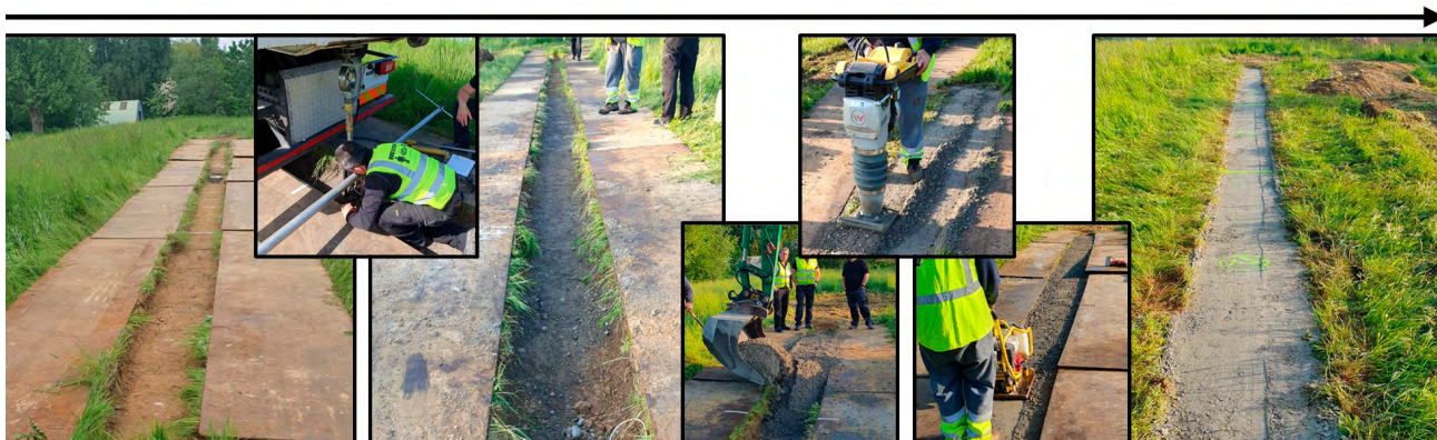
Figuur 1 – Uitvoeringsstappen van de fundering in schraal beton op de site van Sterrebeek. © OCW
