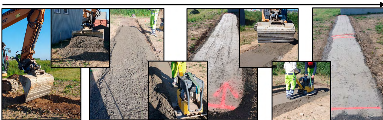
Figuur 3 – Uitvoeringsstappen van de fundering in schraal beton op de site van Fernelmont. © OCW
