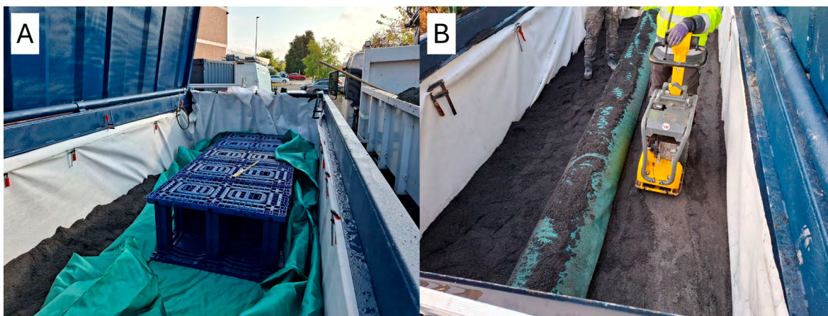
Figuur 2 – Installatie van de twee eerste infiltratiesystemen in de testopstelling.
