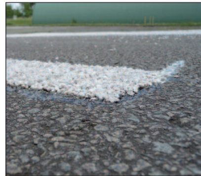
Figuur 5 – Uiteindelijke markering (eenlaags uitgevoerd)
