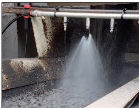
Figuur 3 – Toevoeging van het verjongingsmiddel aan het asfaltmengsel met behulp van een volumegestuurde sproei-installatie
