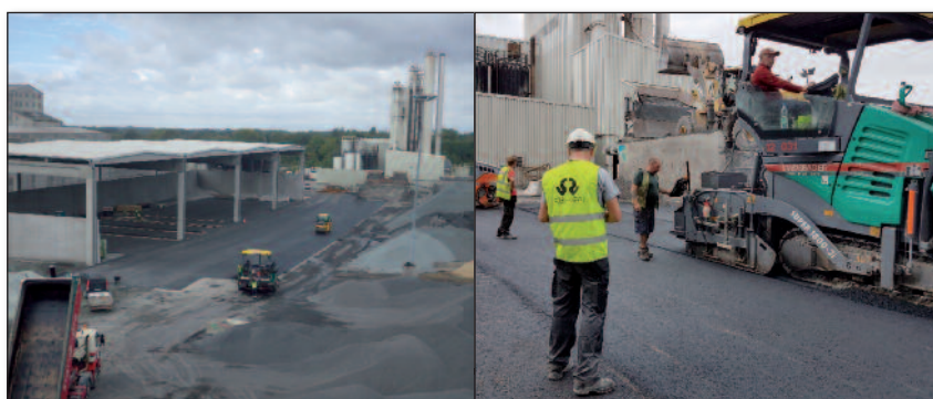
Figuur 2 – Aanleg van de proefvakken op de productiesite van de nv Stadsbader te Vaulx
