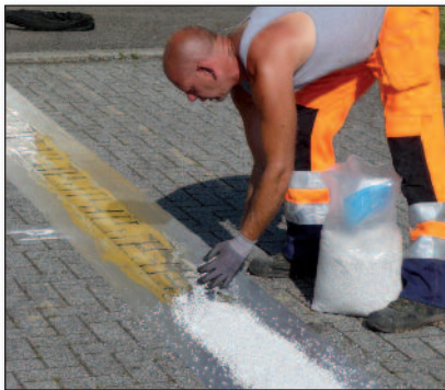
Figuur 3 – Afstrooien van het nog vloeibare hars met wit steenslag
