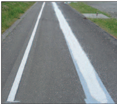
Figuur 4 – Proefzone op asfalt: eenlaagse markering links en tweelaagse markering (in uitvoering) rechts
