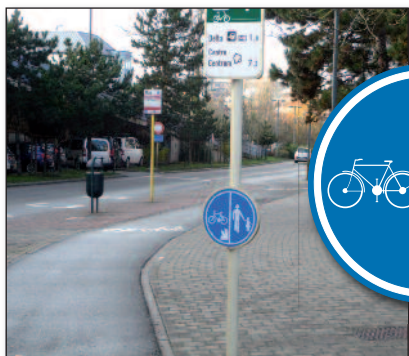
Figuur 1 – Fiets- en voetpad D9 (betonstraatstenen voor voetgangers en zwart asfalt voor fietsers)
