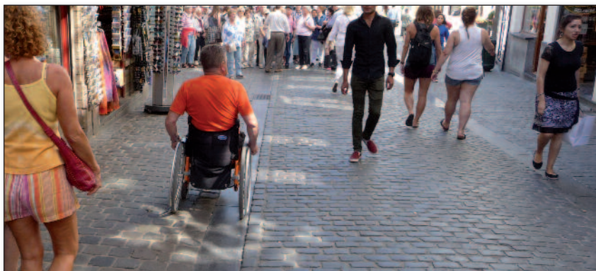
Figuur 1 – Deze rolstoelgebruiker rijdt (gedeeltelijk) op de verharding die het best aan zijn behoeften (hier: vlakheid) tegemoetkomt
