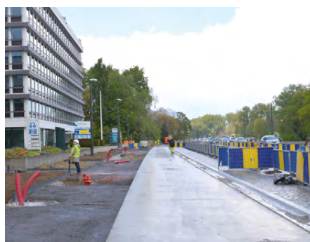
Routes en béton et pavages
