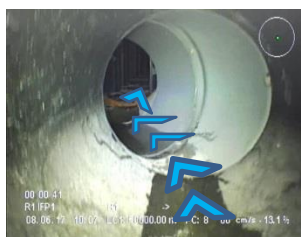
(Foto 7) Inwendig axiaal beeld infiltratiebekken Nr.3
