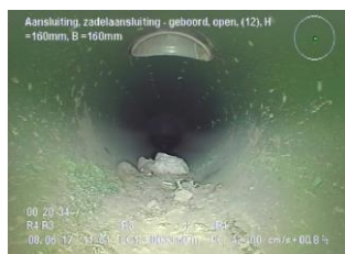
(Foto 5) Zadelaansluiting in IT-leiding
