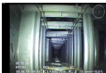
(Foto 9) Inwendig axiaal beeld infiltratiebekken
