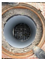
(Foto 6) Inspectieschouw infiltratiebekken Nr.3
