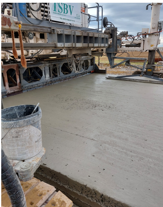
Figure 7 – «Déchirements» de la surface observés lorsqu'une vitesse rapide est combinée avec une fréquence faible de vibration
