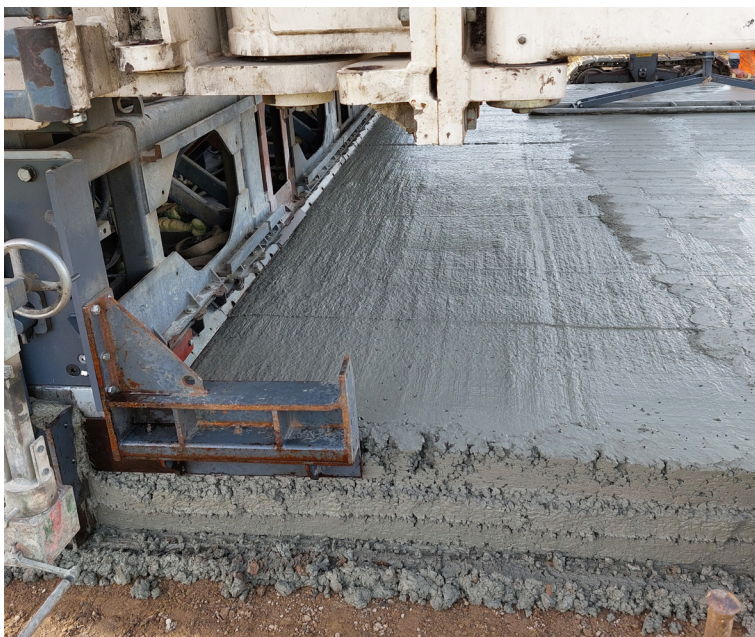
Figure 6 – Irrégularités de surface observées lorsqu'une vitesse lente est utilisée en combinaison avec une fréquence de vibration élevée
