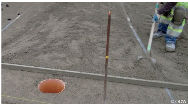
Profileren en effenen van een mortelbed voor natuursteentegels
