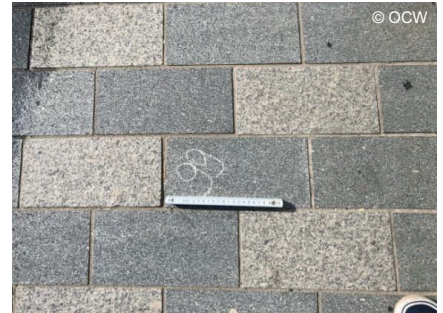
Gezaagde en gevlamstraalde granietkeien op het Spiegelplein (Jette), met een zeer goede gebruikskwaliteit (comfort = 10/10, stroefheid (PFT) = 0,69)
