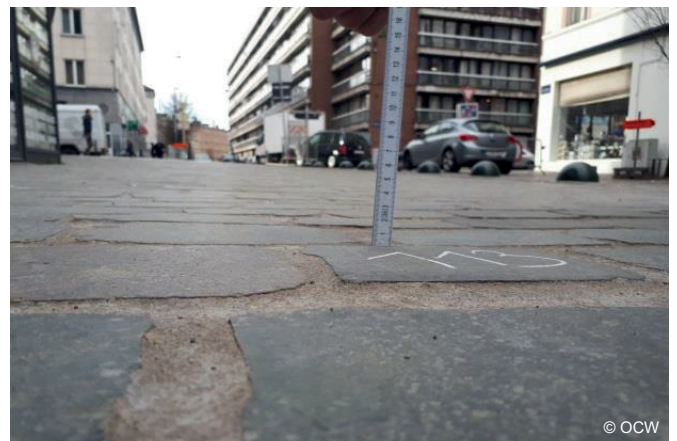
Gezaagde porfierstenen met een identiek oppervlak maar een verschillend comfort (gemeenteplein in Molenbeek): links voegen van \pm 4 mm diep, comfort = 5,6/10; rechts: voegen van \pm 1 mm diep, comfort = 7,5/10
