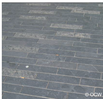
Natuursteenbestrating met afwisselend gepolijste en onbewerkte straatkeien (links). Aan de gepolijste oppervlakken te zien, is het gevaar om uit te glijden links hoger dan rechts, waar er minder gepolijste stenen tussen de granietstenen liggen
