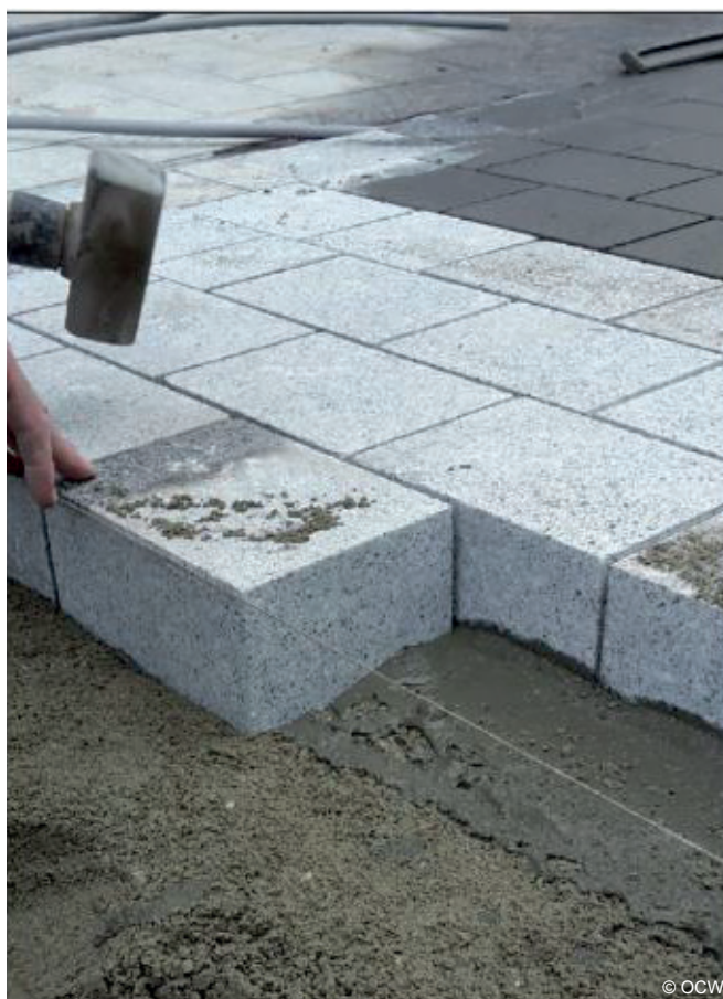
Aanbrengen van gezaagde natuurstenen straatkeien met een "hechtlaag" tussen straatlaag en straatkei
