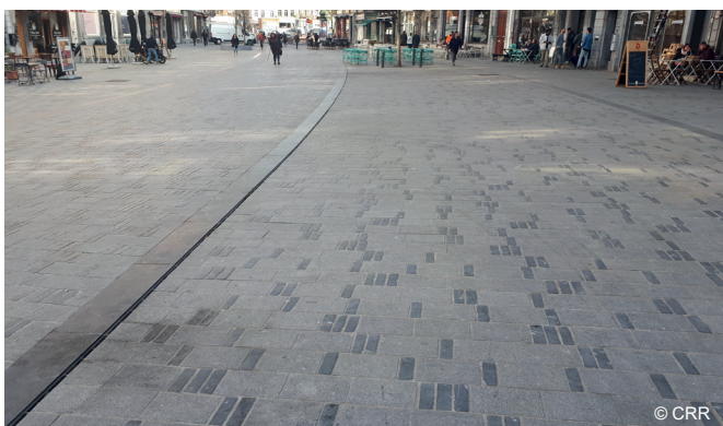
Natuursteenbestrating met afwisselend gepolijste en onbewerkte straatkeien (links). Aan de gepolijste oppervlakken te zien, is het gevaar om uit te glijden links hoger dan rechts, waar er minder gepolijste stenen tussen de granietstenen liggen
