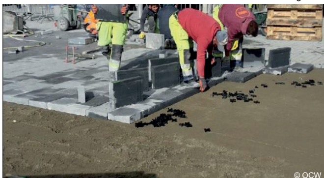
Profileren en effenen van een mortelbed voor natuursteentegels
