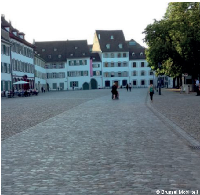
Behandeling van oneffenheden in het oppervlak: (links) comfortstrook met gezaagde straatkeien in een rijbaan met klassieke straatkeien in Bazel; (rechts): betonnen verharding in Lyon, na aanbrenging op verzoek van de gebruikers afgeschuurd om oneffenheden en het ervaren ongemak weg te nemen
