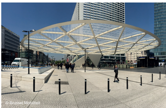
Een te lichtgekleurde verharding verblindt de gebruiker
