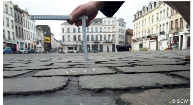
Gezaagde porfierstenen met een identiek oppervlak maar een verschillend comfort (gemeenteplein in Molenbeek): links voegen van \pm 4 mm diep, comfort = 5,6/10; rechts: voegen van \pm 1 mm diep, comfort = 7,5/10
