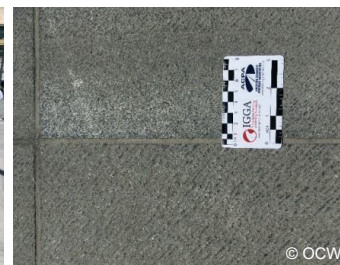
Tegels van blauwe hardsteen met oppervlakafwerking in de buurt van het Noordstation, met een zeer goede gebruikskwaliteit (comfort = 10, stroefheid (PFT) = 0,77)
