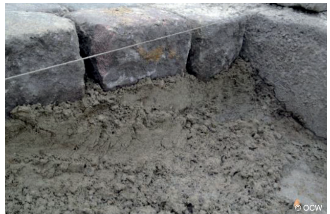
Straatlaag van zandcement
