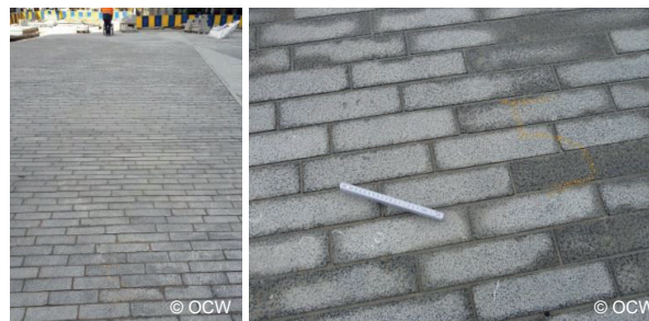
Gezaagde straatkeien van gebouchardeerde blauwe hardsteen op een voetgangersvoorziening in Brussel, met een zeer goede gebruikskwaliteit (comfort = 9,5/10, stroefheid (PFT) = 0,85)
