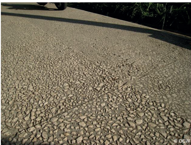
Behandeling van oneffenheden in het oppervlak: (links) comfortstrook met gezaagde straatkeien in een rijbaan met klassieke straatkeien in Bazel; (rechts): betonnen verharding in Lyon, na aanbrenging op verzoek van de gebruikers afgeschuurd om oneffenheden en het ervaren ongemak weg te nemen
