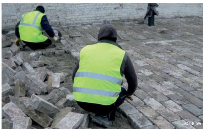
Inbedden van straatkeien in een straatlaag
