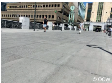
Tegels van blauwe hardsteen met oppervlakafwerking in de buurt van het Noordstation, met een zeer goede gebruikskwaliteit (comfort = 10, stroefheid (PFT) = 0,77)
