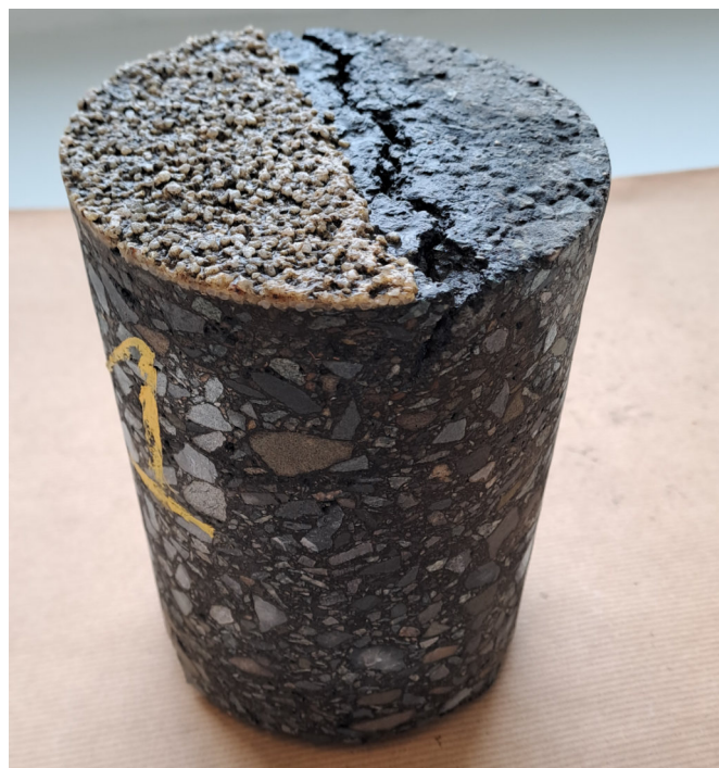
Figuur 7 - Langse scheur langs rand epoxyzone, scheurpropagatie naar onder in de asfalttoelaag
