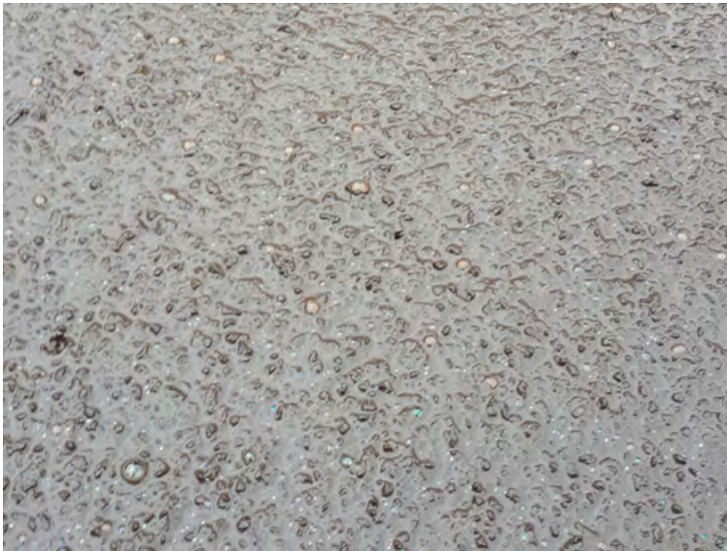
Figuur 4 – Vorming van bellen aan de oppervlakte van de slem op basis van latex
