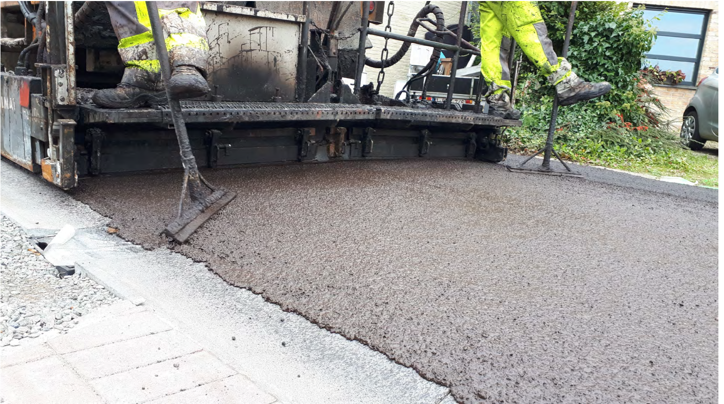
Figuur 3 – Uitvoering van een tweelaagse slem op een werf in Oost-Vlaanderen, in 2021
