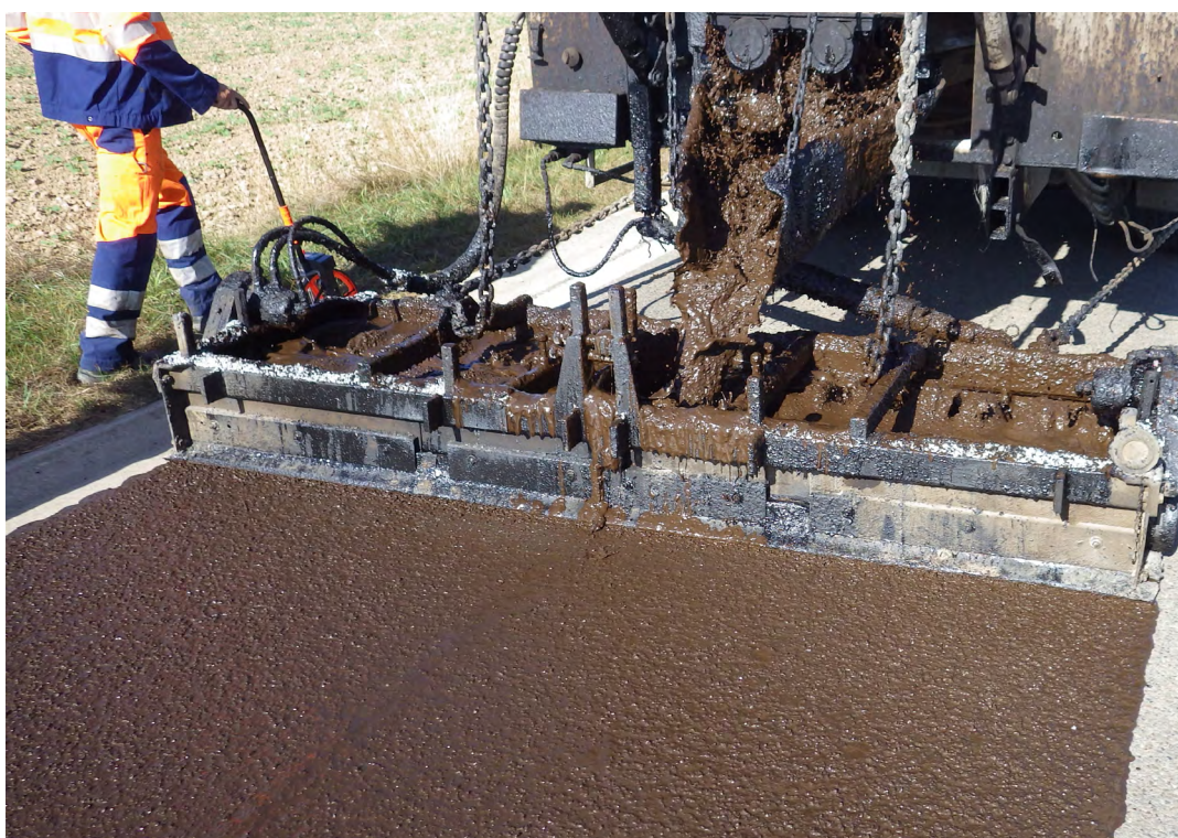
Figuur 1 - Uitvoering van een slemlaag
