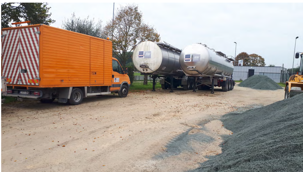
Figuur 5 – Materiaalopslagplaats voor de slemwerf
