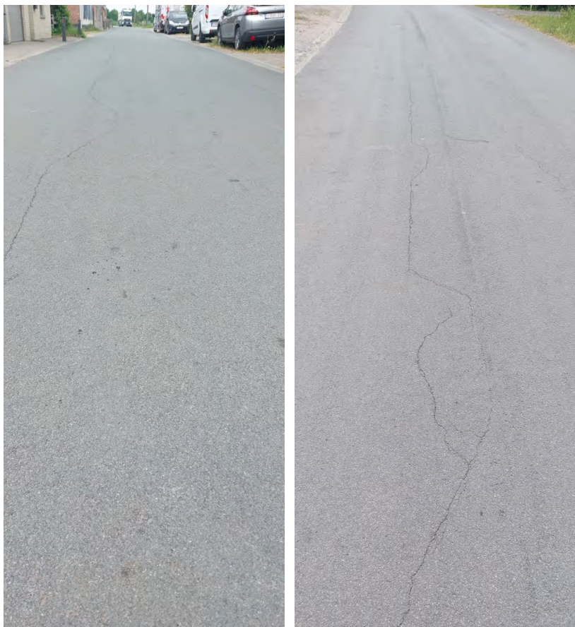
Figure 15 – Vue globale de l'état du MBCF en mai 2025
