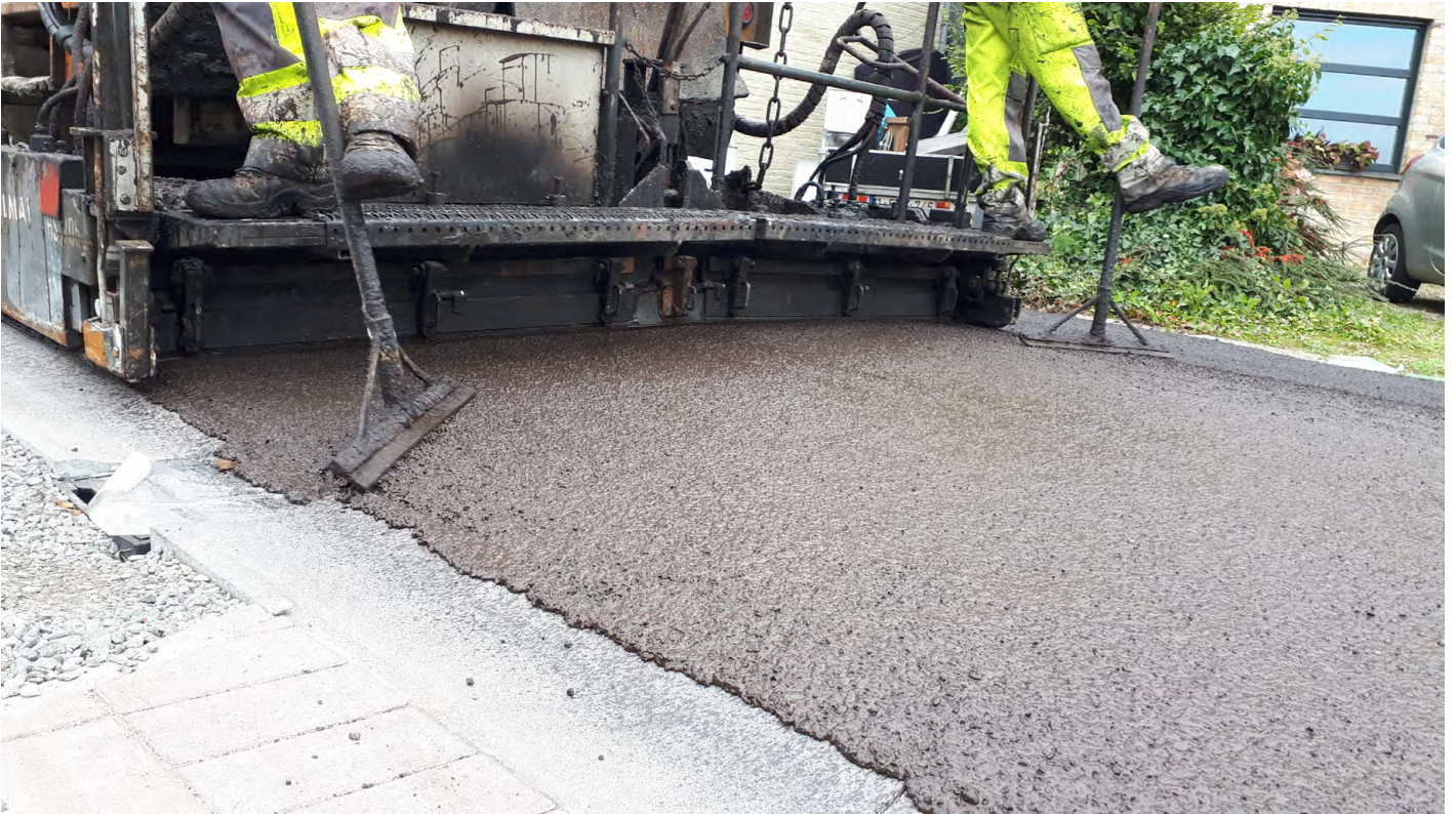
Figure 3 – Mise en œuvre en 2021 d'un MBCF bicouche sur un chantier en Flandre Orientale
