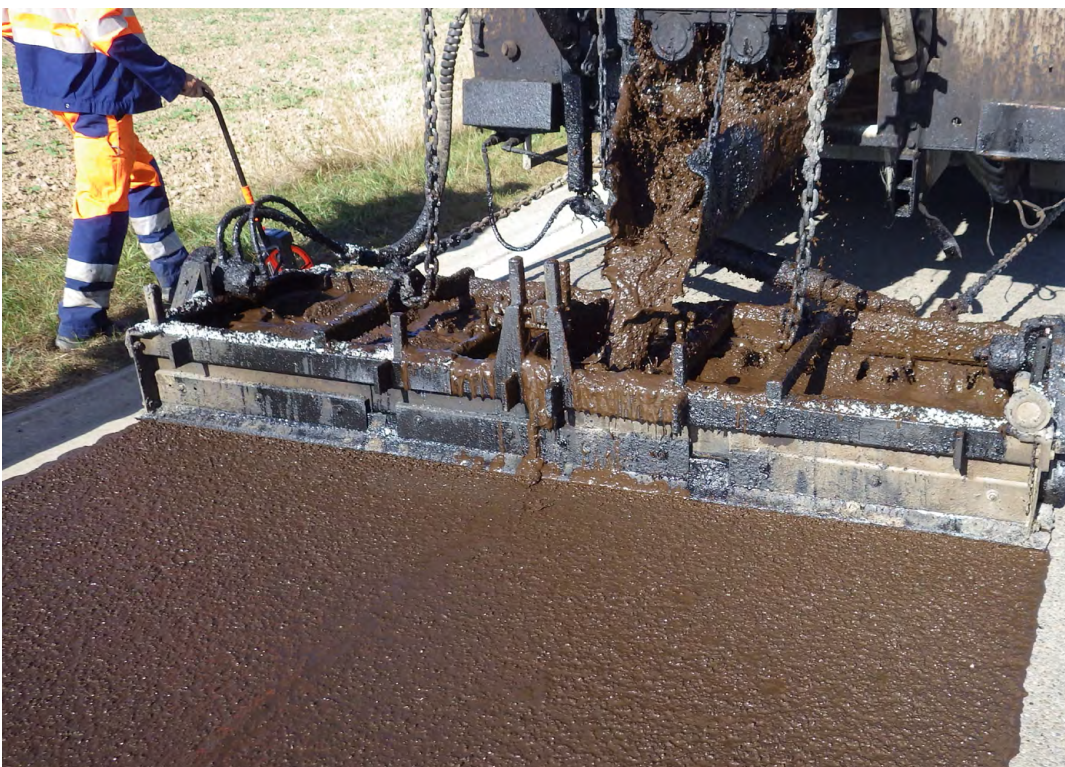
Figure 1 – Mise en œuvre d'un MBCF
