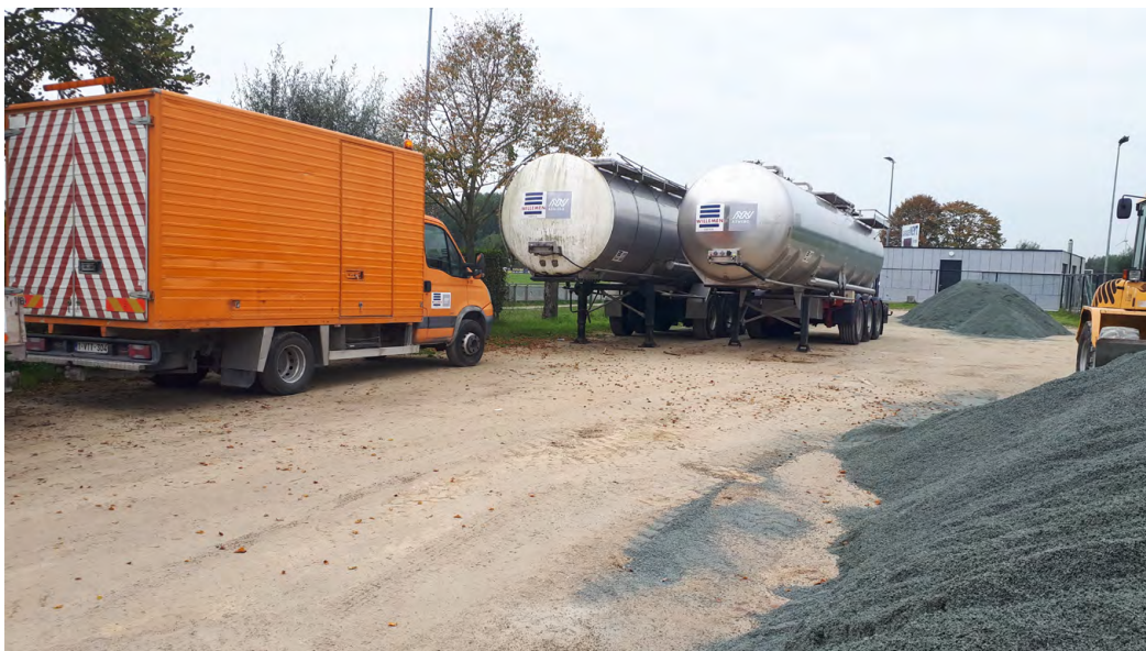
Figure 5 – Lieu de stockage des matériaux du chantier de MBCF
