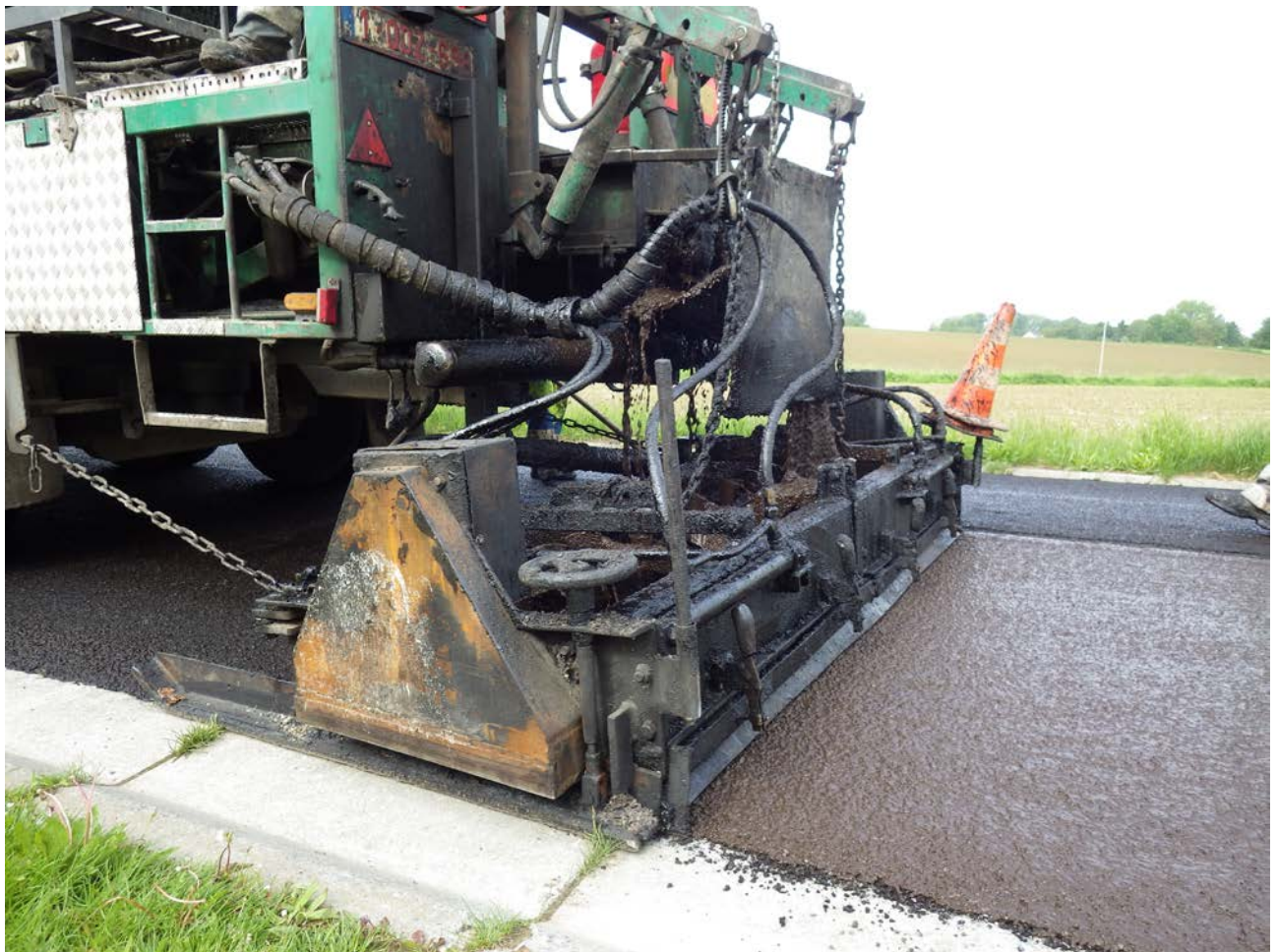
Figuur 1 – Slem aan de achterzijde van de slemmachine
