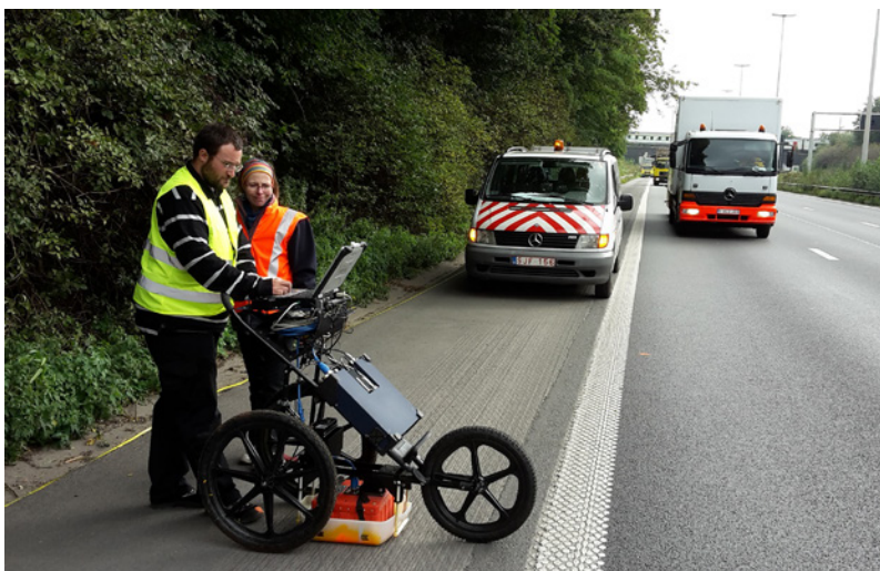
Figuur 7 – Grondradarmeting op de weg om plaatselijke probleemzones te detecteren
