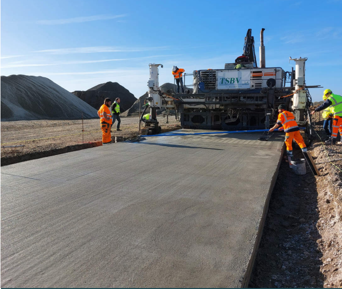
Figure 2 - Section d'essai du projet MONOCRETE à Bierset
