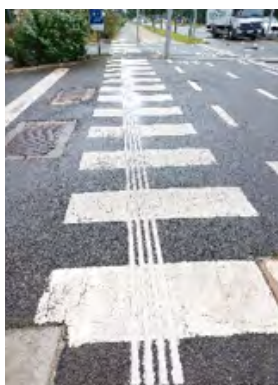
Specifieke markering met gegroefde zelfklevende strips
