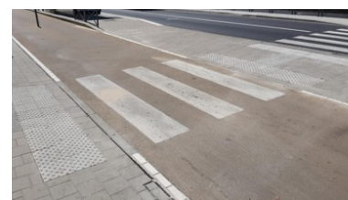
Marquage en pavés synthétiques sur résine à Madou (2020)
