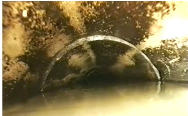
Figure 82 - Déplacement radial (source: CRR)
