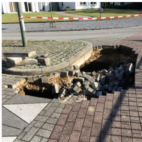
Figure 1 - Dégradations sévères causées par l'effondrement d'une canalisation d'égout (source : CRR)
