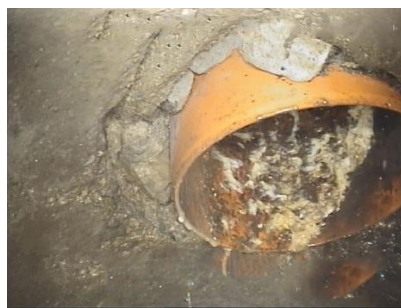
Figure 69 - Prise d'eau ciselée BCA-E (source : BRRC)
