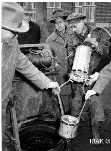
Figure 2 - Système d'inspection IBAK (source : IBAK)
