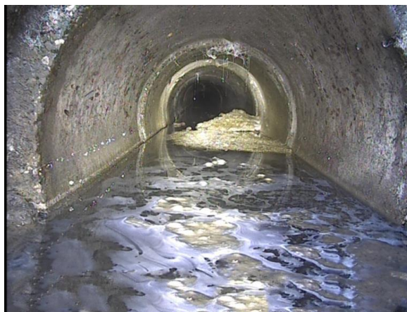
Figure 16 – Photo stationnaire ; dépôt décanté + formation d'une croûte > 25 % (source : CRR)
