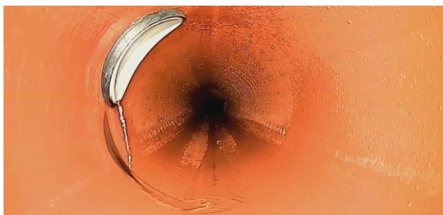
Figure 68 - Prise d'eau avec fixation de la selle BCA-B (source : CRR)
