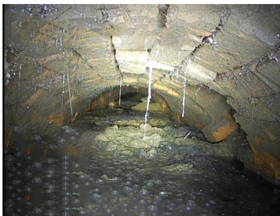
Figure 15 - Photo stationnaire ; dépôt sédimentaire > 80 % (source : CRR)
