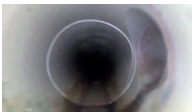
Figure 32 – Image en direct – Têtes de nettoyage avec caméra intégrée (source : Sewer Robotics)
