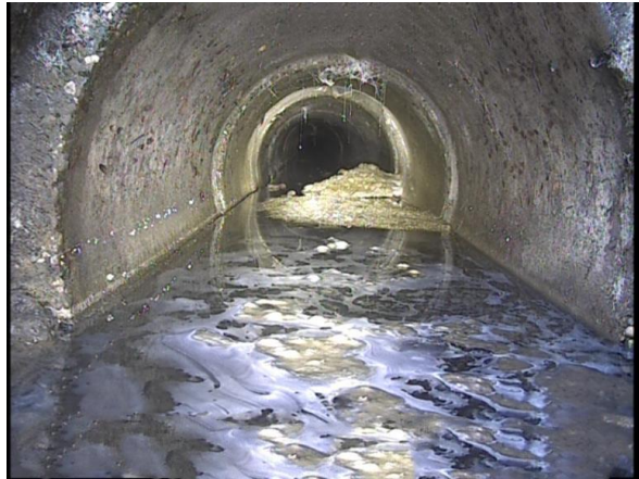
Foto 16 (Bron BRRC) Foto stationair genomen; bezonken afzetting + korstvorming >25%
