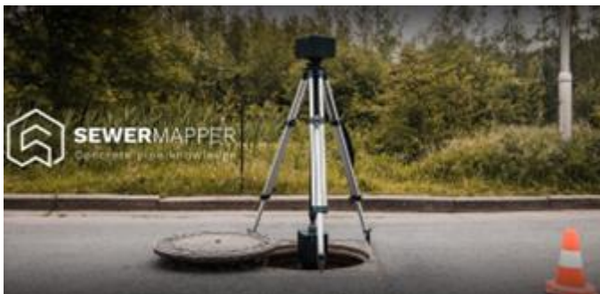
Foto 46 (Bron SewerMapper) Sewer Mapper-Toestel
