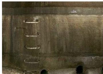
Foto 44 (Bron Sewervision) “3D-Cleverscan” – Uitgeklapt beeld
