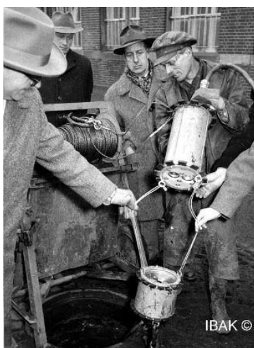
Foto 2 (Bron IBAK) Inspectie systeem IBAK
