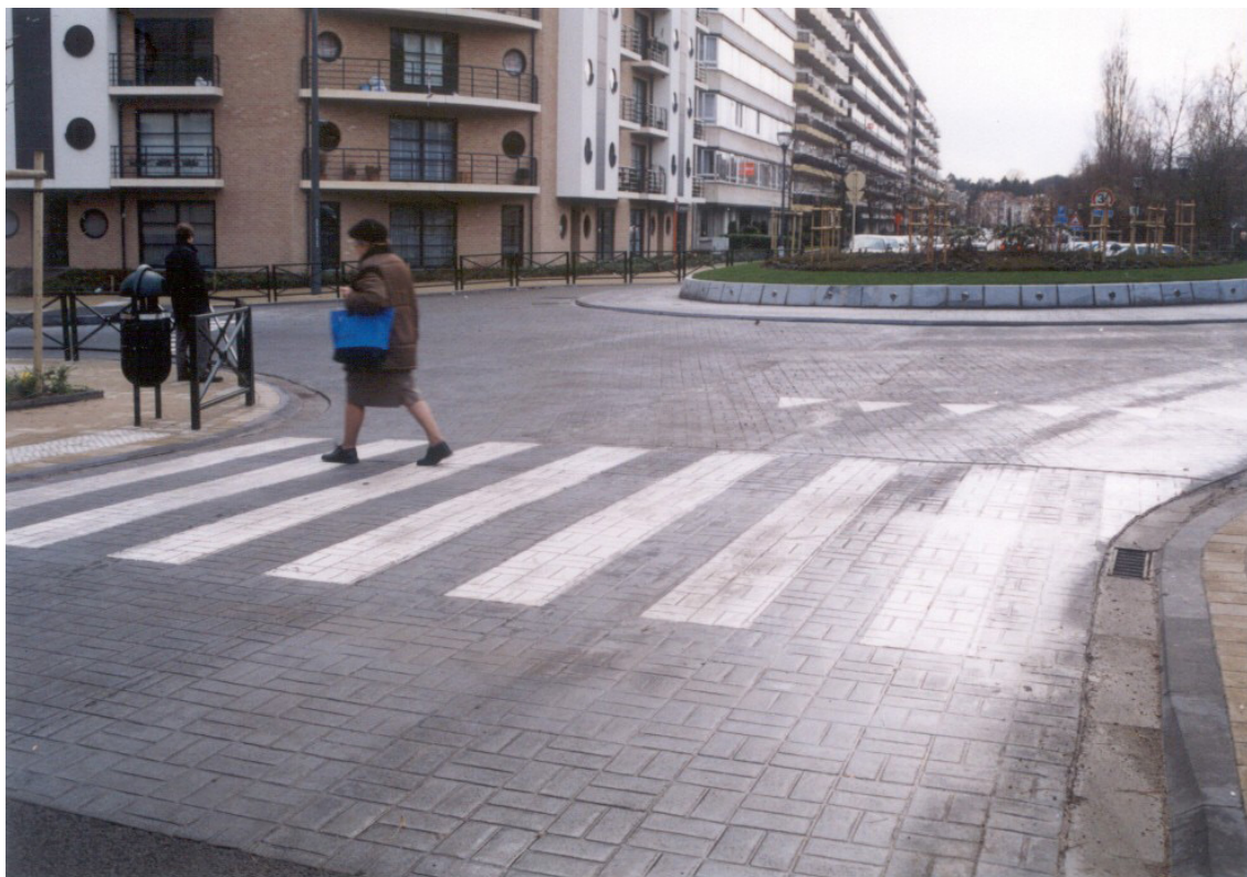
Figure 1.1 – Plusieurs champs d'application possibles du béton imprimé dans la construction routière : a) Koekelberg – carrefour en béton imprimé avec motif de pavés en béton en appareillage à pavés couplés
