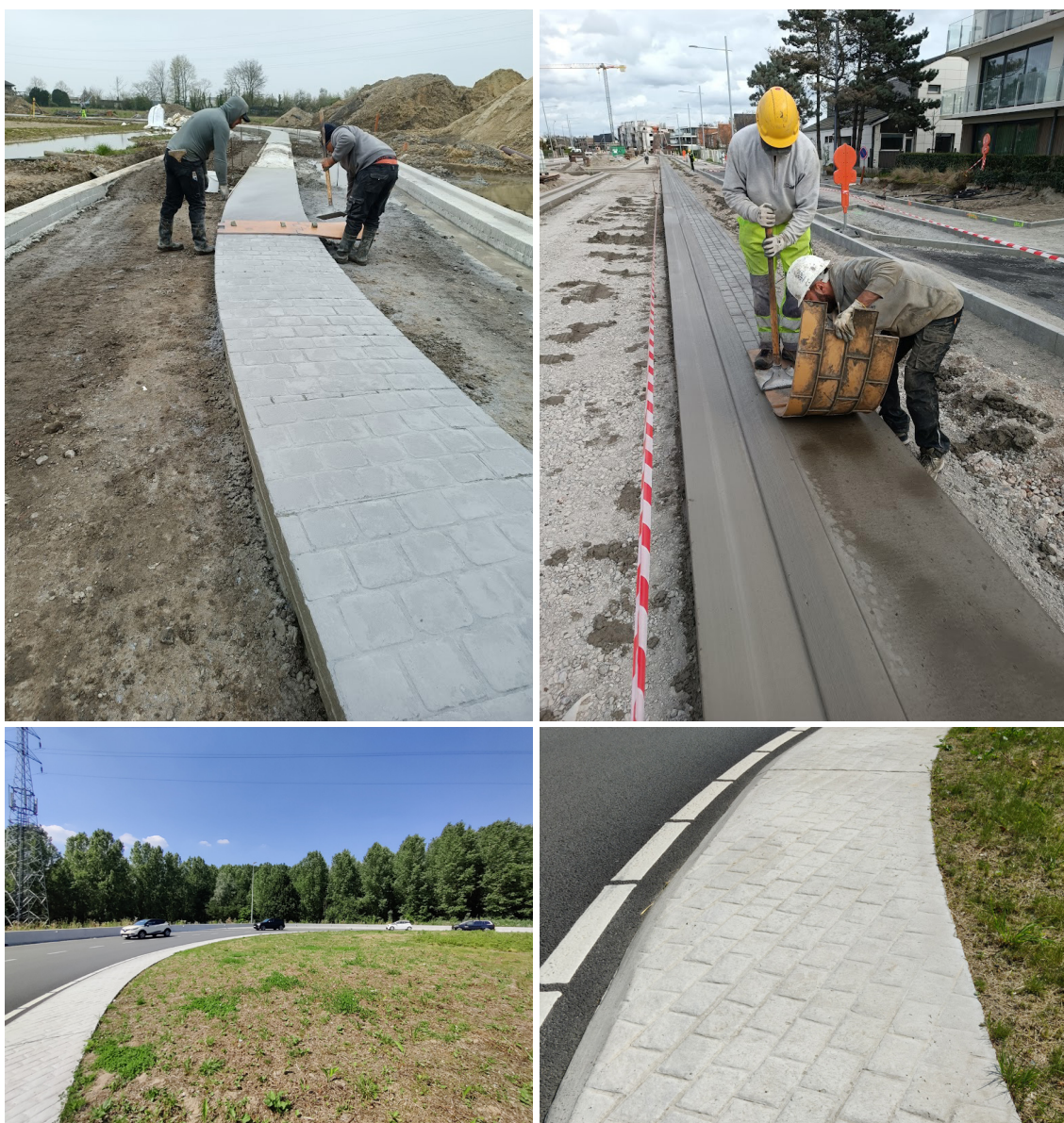
Figure 2.3 – Béton imprimé – système 3A – Pose avec coffrages glissants et moules d'impression; en haut : réalisation d'une construction linéaire étroite ©SICO Aannemingen; en bas : application sur un anneau franchissable en combinaison avec une bordure à Affligem ©Febelcem
