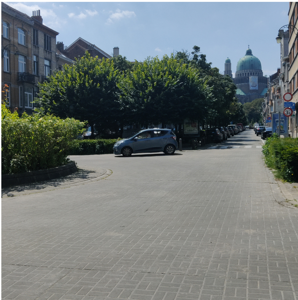
Figure 8.1 – Rond-point en béton imprimé à motif de pavés de béton avec appareillage à pavés couplés sur l'avenue Broustin à Ganshoren (posé en 2002, photo prise en juin 2024). (©Febelcem)
