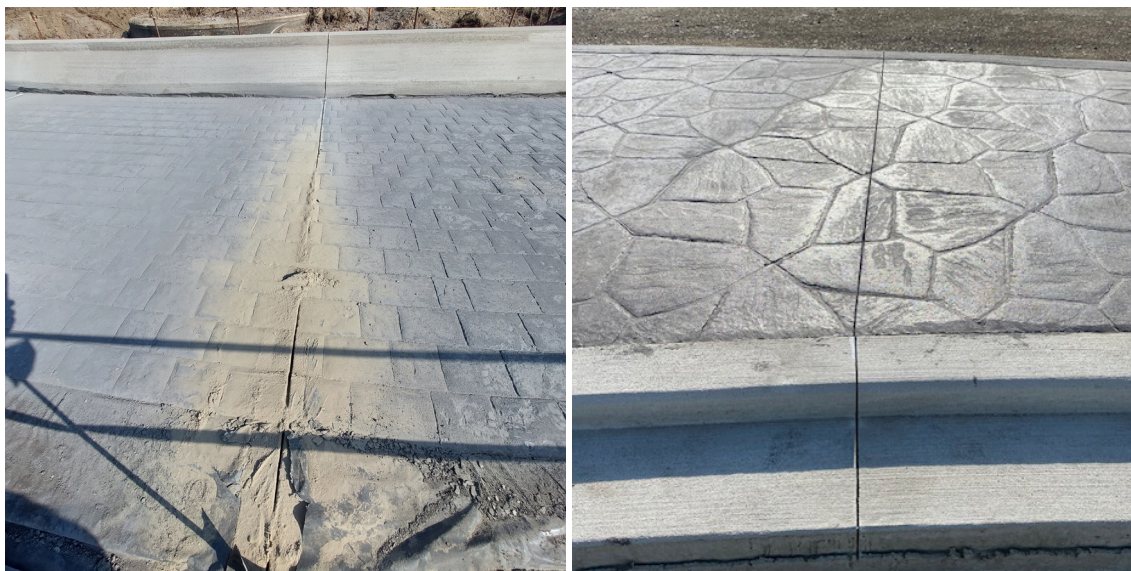
Figure 4.10 – Réalisation de joints de retrait dans du béton imprimé, correctement sciés en alignement sur le joint adjacent de l'élément linéaire afin d'empêcher les fissures de sympathie (à gauche : ©ELB, à droite : ©AWV)
