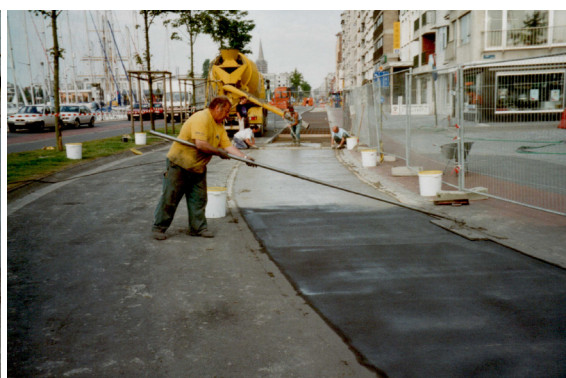
Incorporation du colorant durcisseur et lissage du béton
