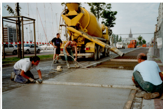
Compactage et lissage
