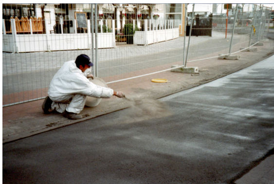
Application de la poudre de démoulage
