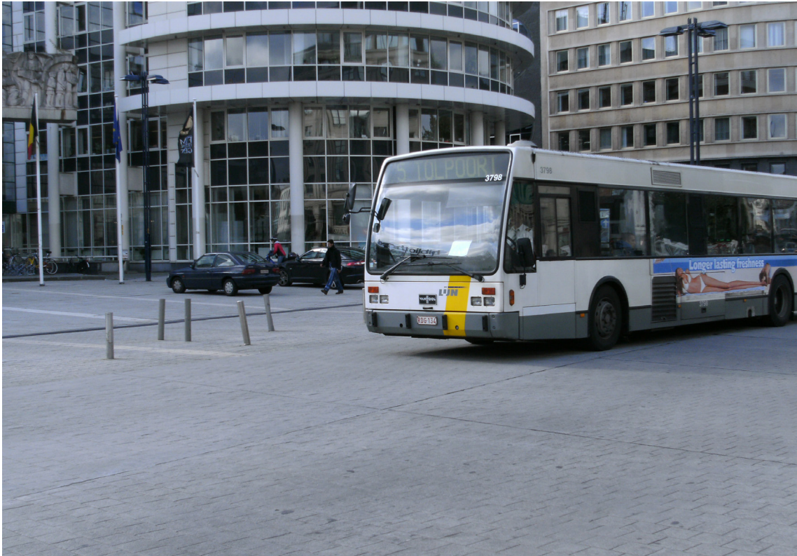
Figure 1.1 – Plusieurs champs d'application possibles du béton imprimé dans la construction routière : b) Gand – Woodrow Wilsonplein, voie de bus en béton imprimé avec motif de pavés en béton
