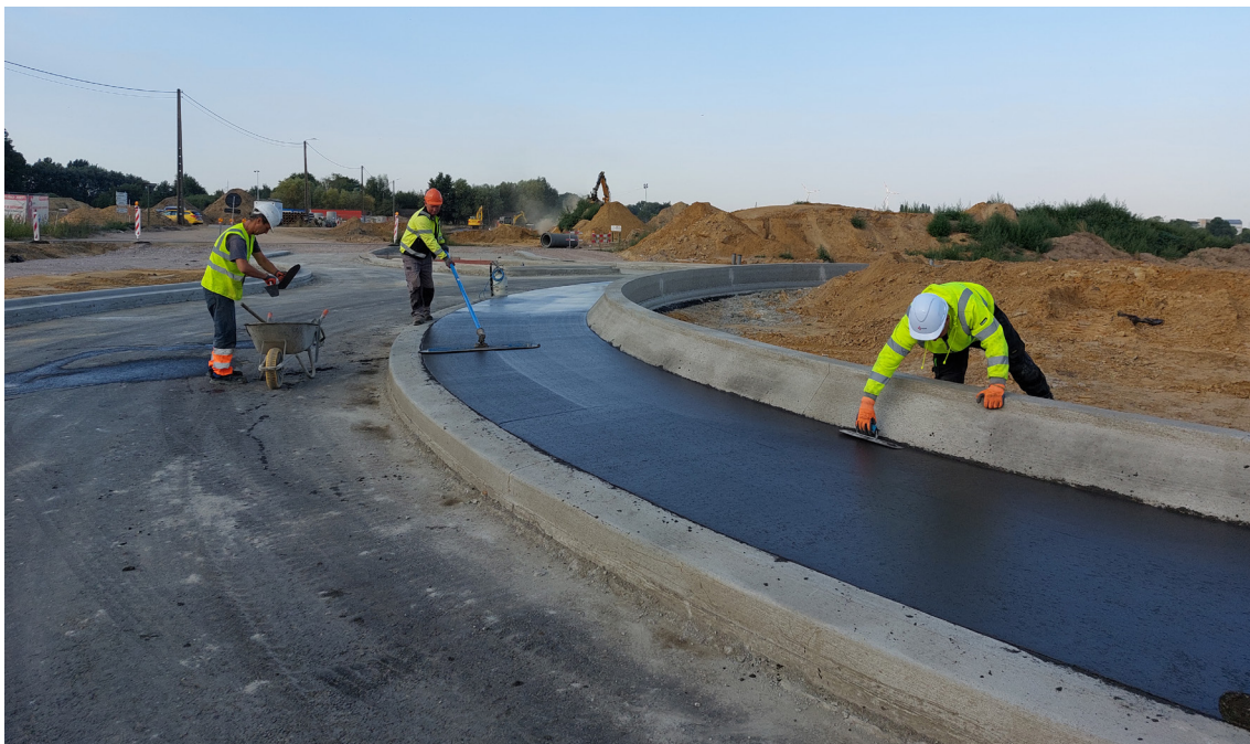
Figure 4.1 – Pose manuelle de béton imprimé sur l'anneau franchissable d'un rond-point. Le compactage s'effectue à l'aide d'aiguilles vibrantes.
