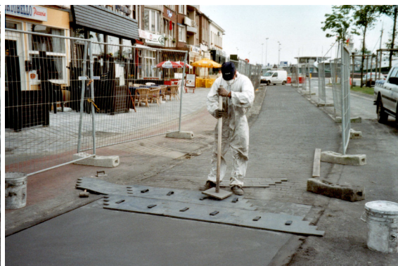
Impression du béton avec moule en plastique
