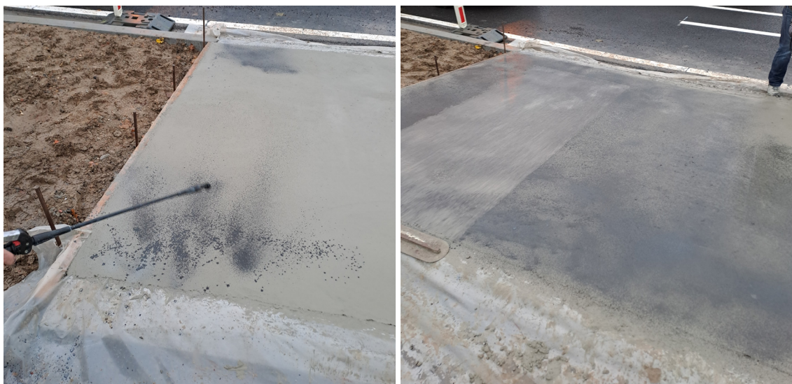
Figure 3.1 – Application d'un colorant durcisseur liquide sur une planche d'essais à hauteur de la N3 à Saint-Trond.
