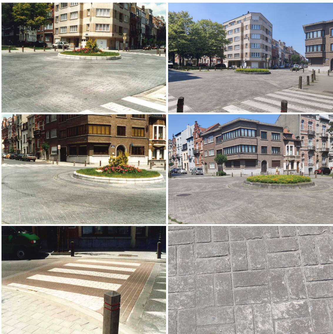
Figure 2.1 – Applications plus anciennes de béton imprimé sur : c) Ronds-points sur l'avenue Broustin à Jette et Ganshoren
