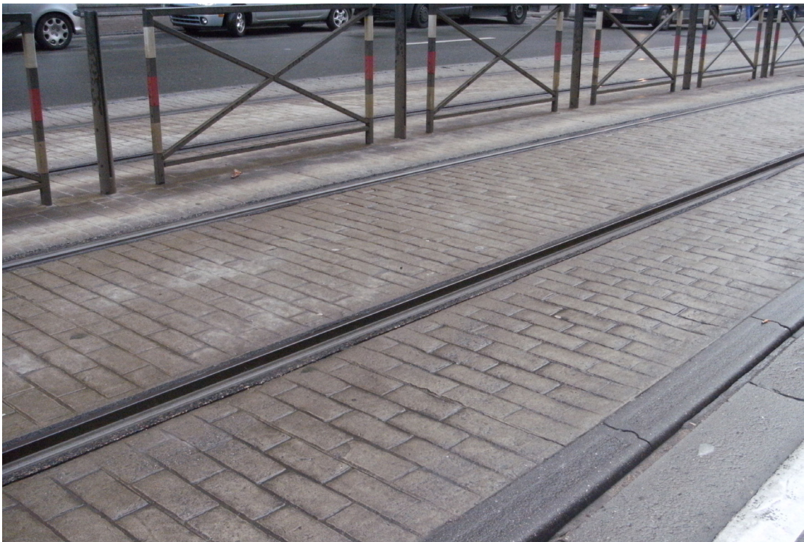
Figure 1.1 – Plusieurs champs d'application possibles du béton imprimé dans la construction routière : c) Bruxelles – avenue Fonsny, voie de tram et de bus en béton imprimé (Photos ©FEBELCEM-CRIC)
