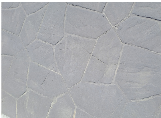
Figure 6.1 – Inspection visuelle d'un revêtement en béton imprimé (©CRR).
