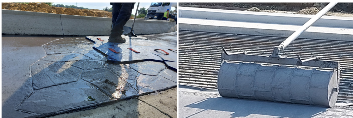
Figure 2.2 – Béton imprimé avec des moules en plastique (à gauche) ou avec un rouleau texturé (à droite).
