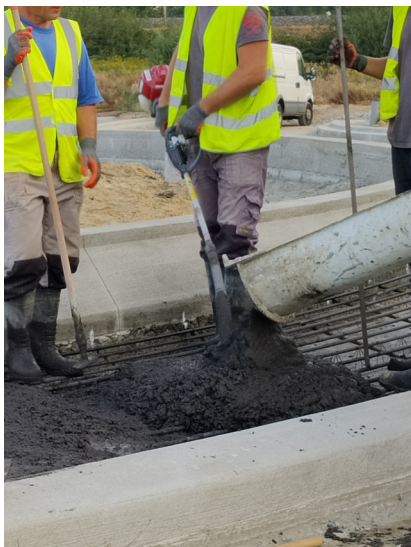
Figure 4.1 – Pose manuelle de béton imprimé sur l'anneau franchissable d'un rond-point. Le compactage s'effectue à l'aide d'aiguilles vibrantes.
