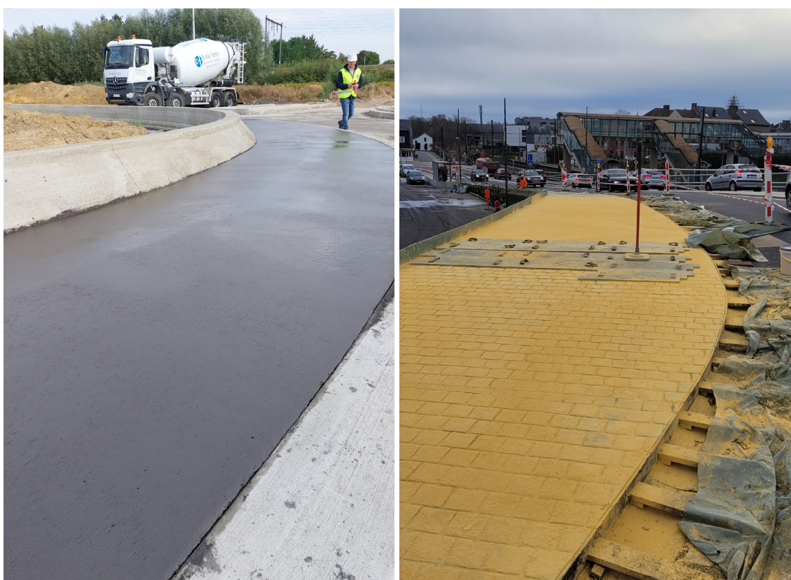
Figure 4.3 – Béton coloré dans la masse pour applications suivant le système 2A : avec 5 % de pigment noir (à gauche, ©CRR) et coloré en jaune (à droite, ©Colas Belgium).
