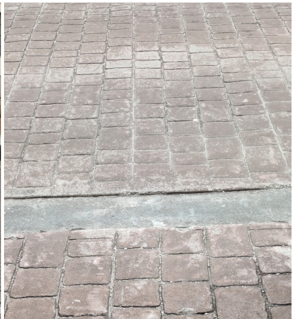
Figure 2.1 – Applications plus anciennes de béton imprimé sur : b) Rue du Luxembourg à Bruxelles
