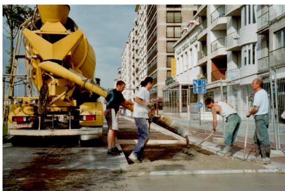
Coulage du béton
