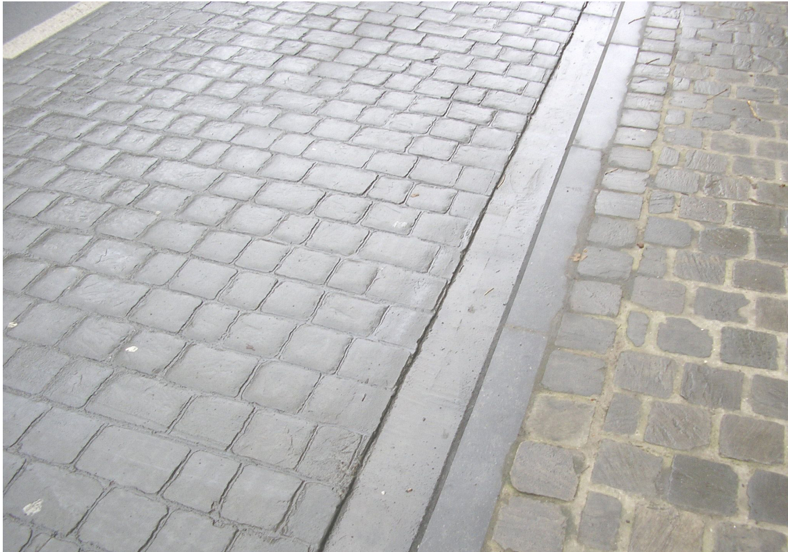
Figure 1.2 - Béton imprimé avec motif de pavés adjacent à un revêtement en véritable pierre naturelle - ©FEBELCEM-CRIC
