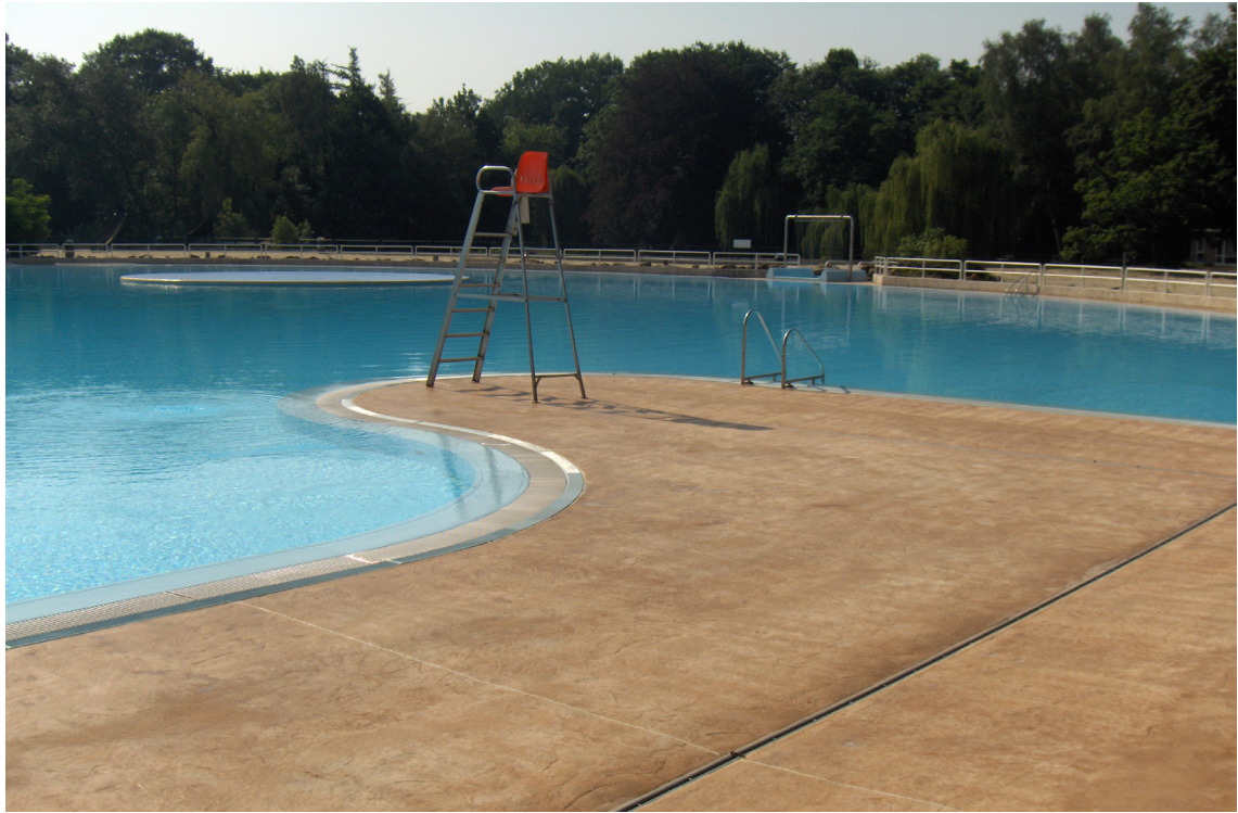
Figure 1.3 – Béton imprimé avec motif «sablonneux» dans une piscine publique - ©FEBELCEM
