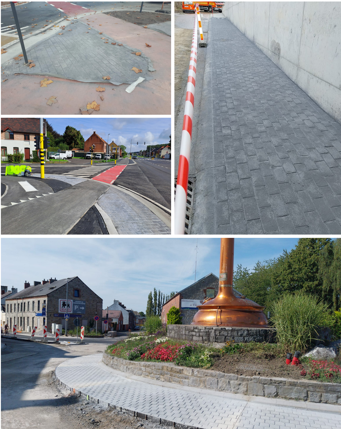
Figure 3.2 – Le béton imprimé est souvent mis en œuvre sur des zones «non circulées», telles que les anneaux franchissables de giratoires, les îlots directionnels, les pistes cyclables, les trottoirs, etc., où la charge de trafic est très faible, voire inexistante (Photos ©CRR, Febelcem, AWW et Colas Belgium).
