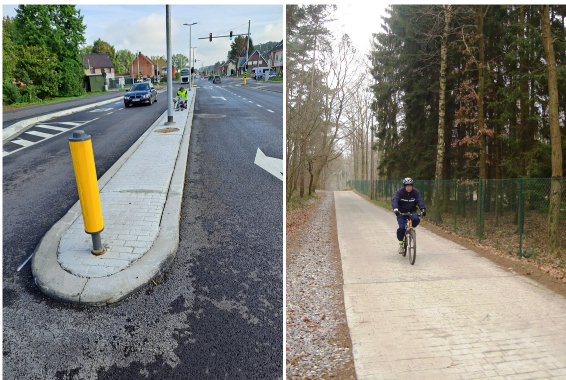
Figure 3.2 – Le béton imprimé est souvent mis en œuvre sur des zones «non circulées», telles que les anneaux franchissables de giratoires, les îlots directionnels, les pistes cyclables, les trottoirs, etc., où la charge de trafic est très faible, voire inexistante (Photos ©CRR, Febelcem, AWW et Colas Belgium).
