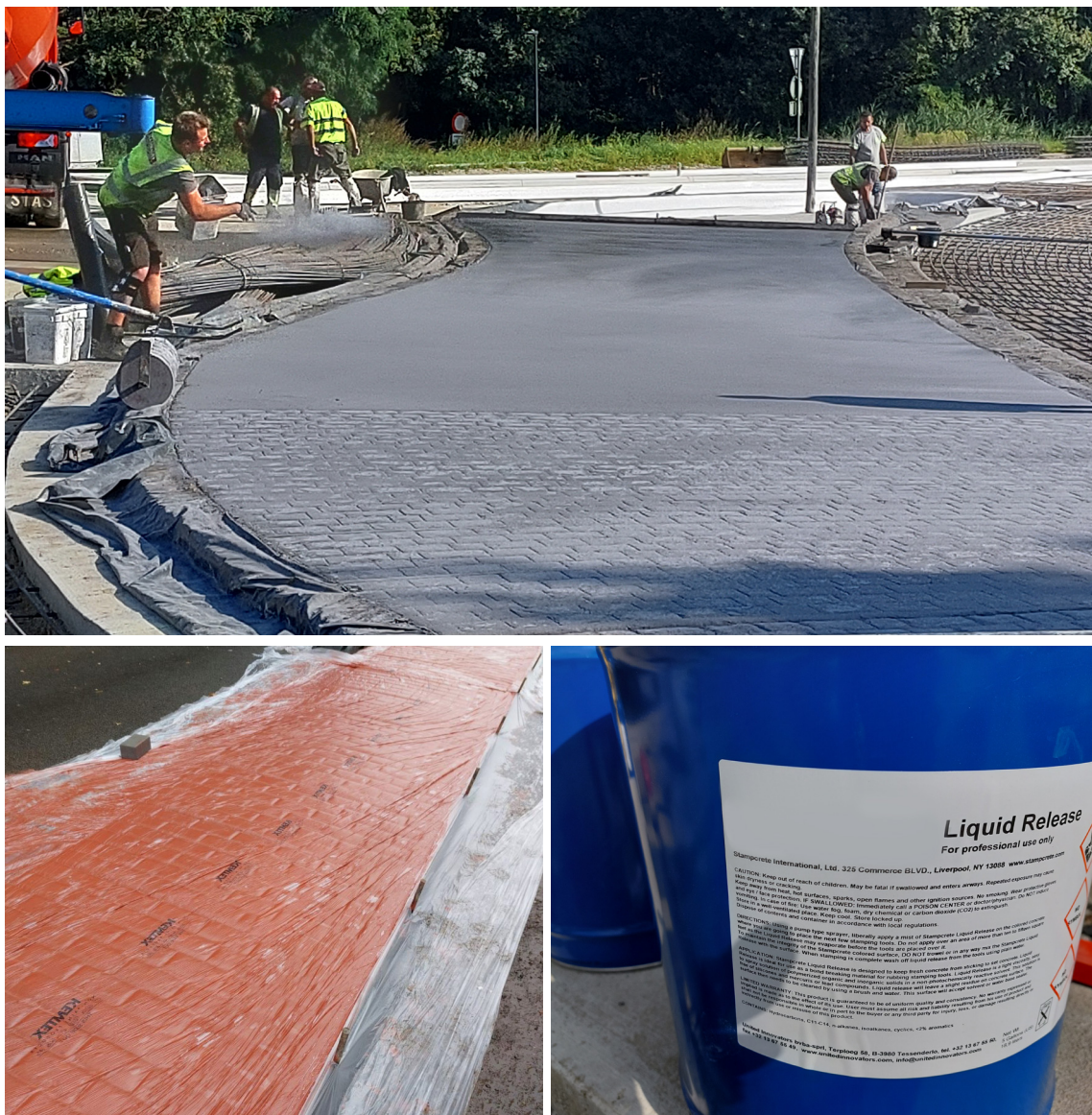
Figure 4.4 – Application de l'agent de démoulage; En haut : poudre de démoulage colorée ou non; En bas à gauche : exemple d'application de béton imprimé avec «film d'impression» (©Roos Group); En bas à droite : agent de démoulage liquide («liquid release»).
