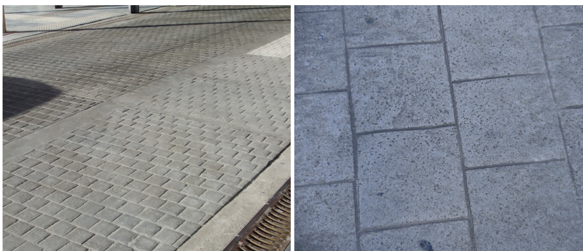
Figure 4.6 – Impression plus profonde avec des moules (à gauche) qu'avec le rouleau (à droite) (©Febelcem).
