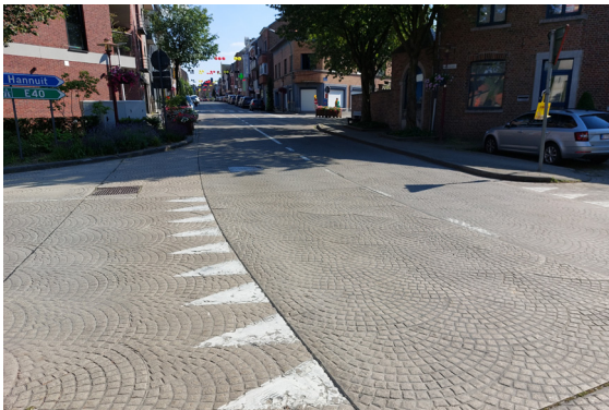
Figuur 2.1 – Oudere toepassingen van gefigureerd beton op: a) Verkeersdrempel in Stationsstraat te Landen Anno juni 2024 (©OCW)
