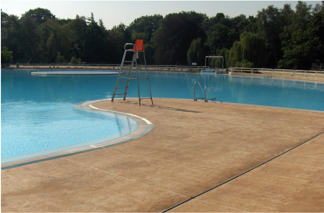
Figuur 1.3 – Gefigureerd beton met een “zanderig” patroon bij een openbaar zwembad - ©FEBELCEM
