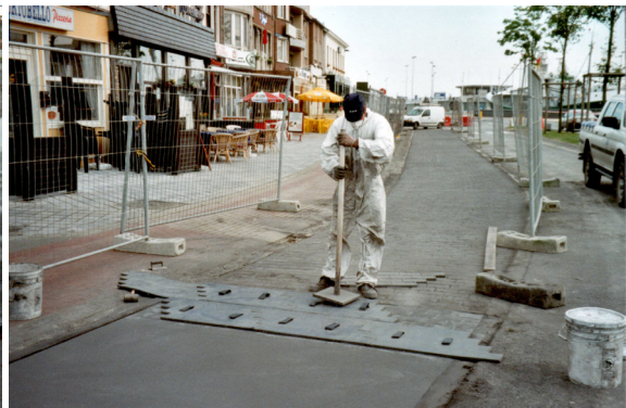
Figureren van beton met kunststof matten
