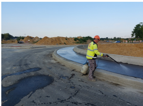
Figuur 4.9 – Toepassing van een tussentijdse nabehandeling met curing compound tussen plaatsen en figureren van beton.
