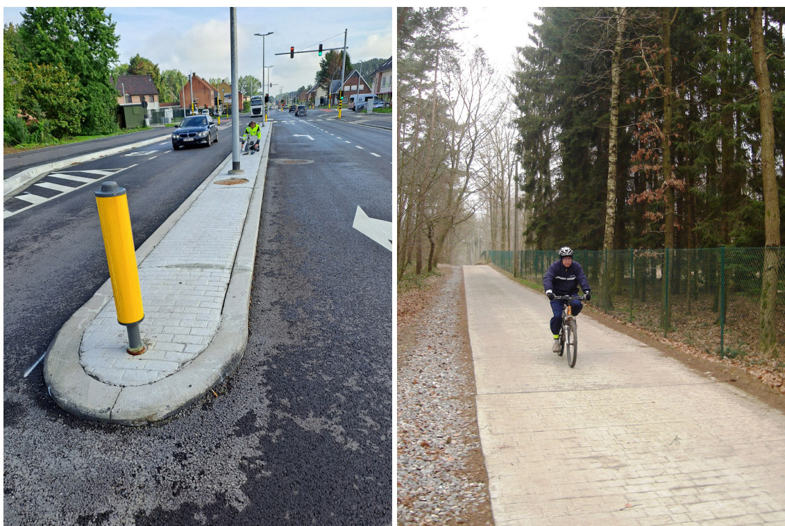
Figuur 3.2 – Typische toepassingen van gefigureerd beton op “niet-bereiden” zones zoals rammelstroken van rotondes, middengeleiders, verkeerseilanden, fiets- of voetpaden, enz. met quasi geen of slechts weinig verkeersbelasting (Foto’s ©OCW, Febelcem, AWV en Colas Belgium).
