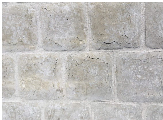
Figuur 6.2 – Microscheuren in gefigureerd beton, waarschijnlijk omwille van een te droog betonmengsel. (©Febelcem)
