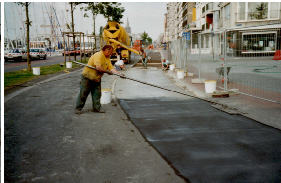
Inwerken kleurverharder en vlakstrijken beton
