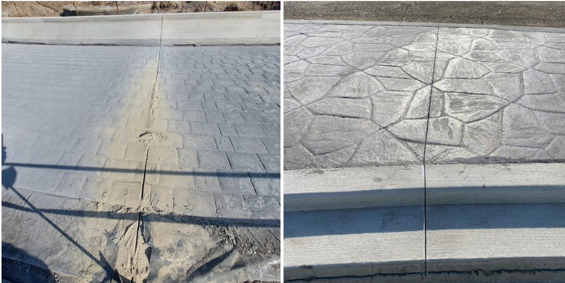
Figuur 4.10 – Uitvoering van krimpvoegen in gefigureerd beton, correct gezaagd in lijn met aanliggende voeg van lijnvormig element om sympathiescheuren te voorkomen (links = ©OCW, rechts = ©AWV).
