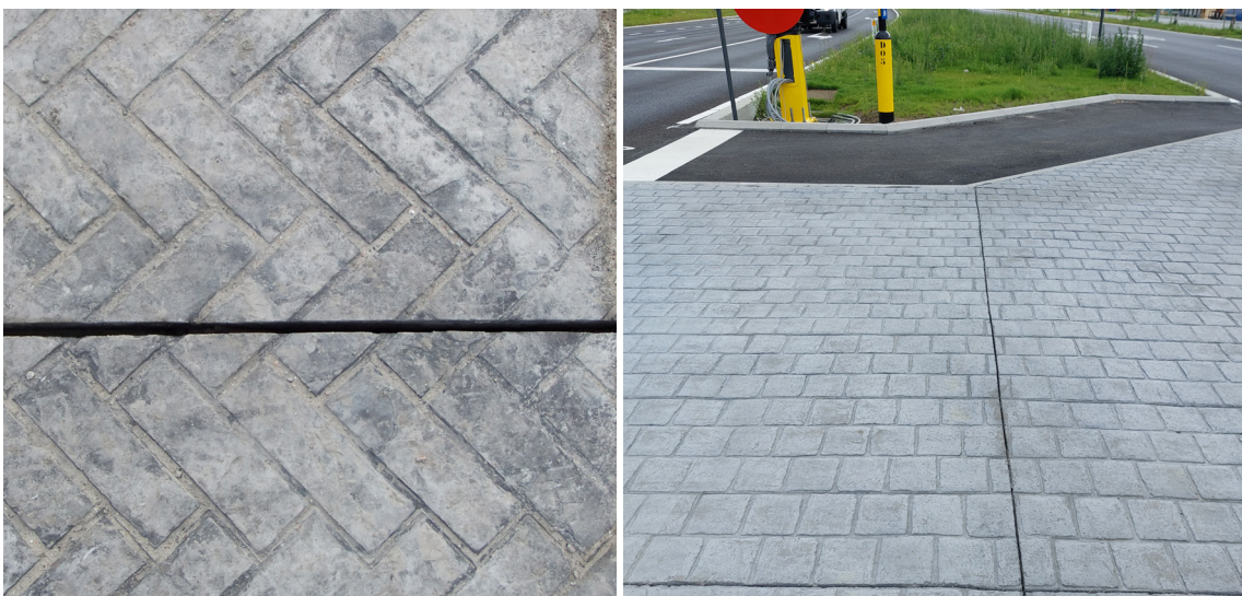
Figuur 4.11 – Krimpvoegen in gefigureerd beton: type 1 (links) [©Febelcem] of type 3 (rechts).
