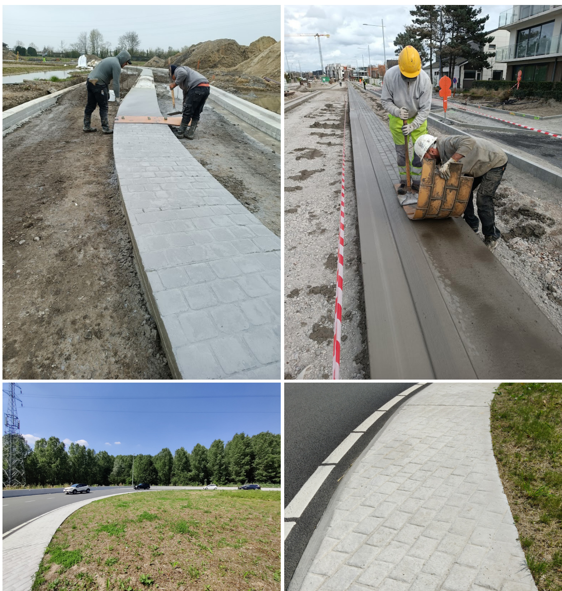
Figuur 2.3 – Gefigureerd beton volgens systeem 3A – Aanleg met glijbekisting en printmatten;
