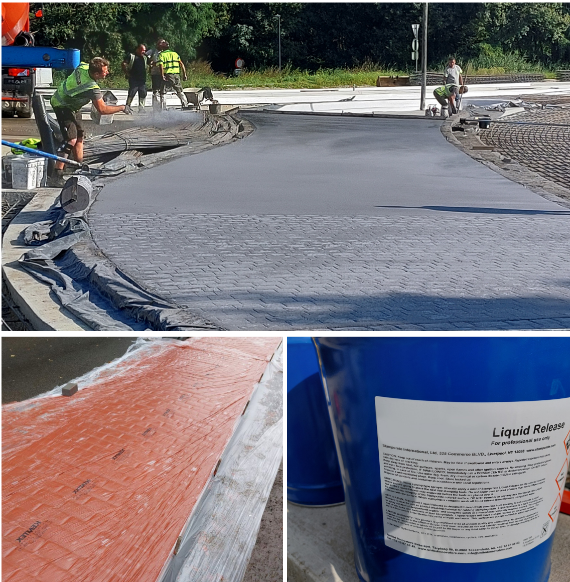
Figuur 4.4 – Aanbrengen van ontkistingsmiddel; Boven: poedervormig en al dan niet gekleurd ontkistingspoeder; Onder, Links: voorbeeld van toepassing van gefigureerd beton met “printfolie” (©Roos Group); Onder rechts: vloeibaar ontkistingsmiddel (“liquid release”).
