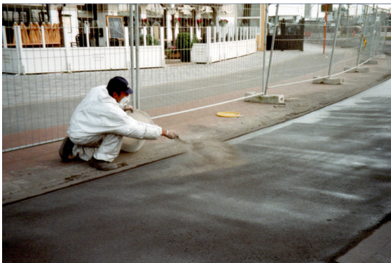
Aanbrengen ontkistingspoeder
