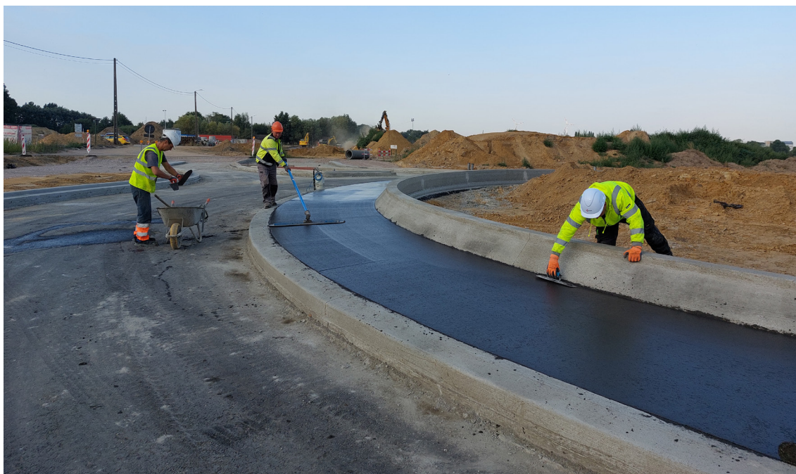
Figuur 4.1 – Manuele aanleg van gefigureerd beton op de rammelstrook van een rotonde. De verdichting gebeurt met behulp van trilnaalden.
