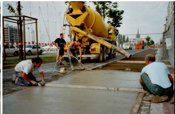
Verdichten en afstrijken
