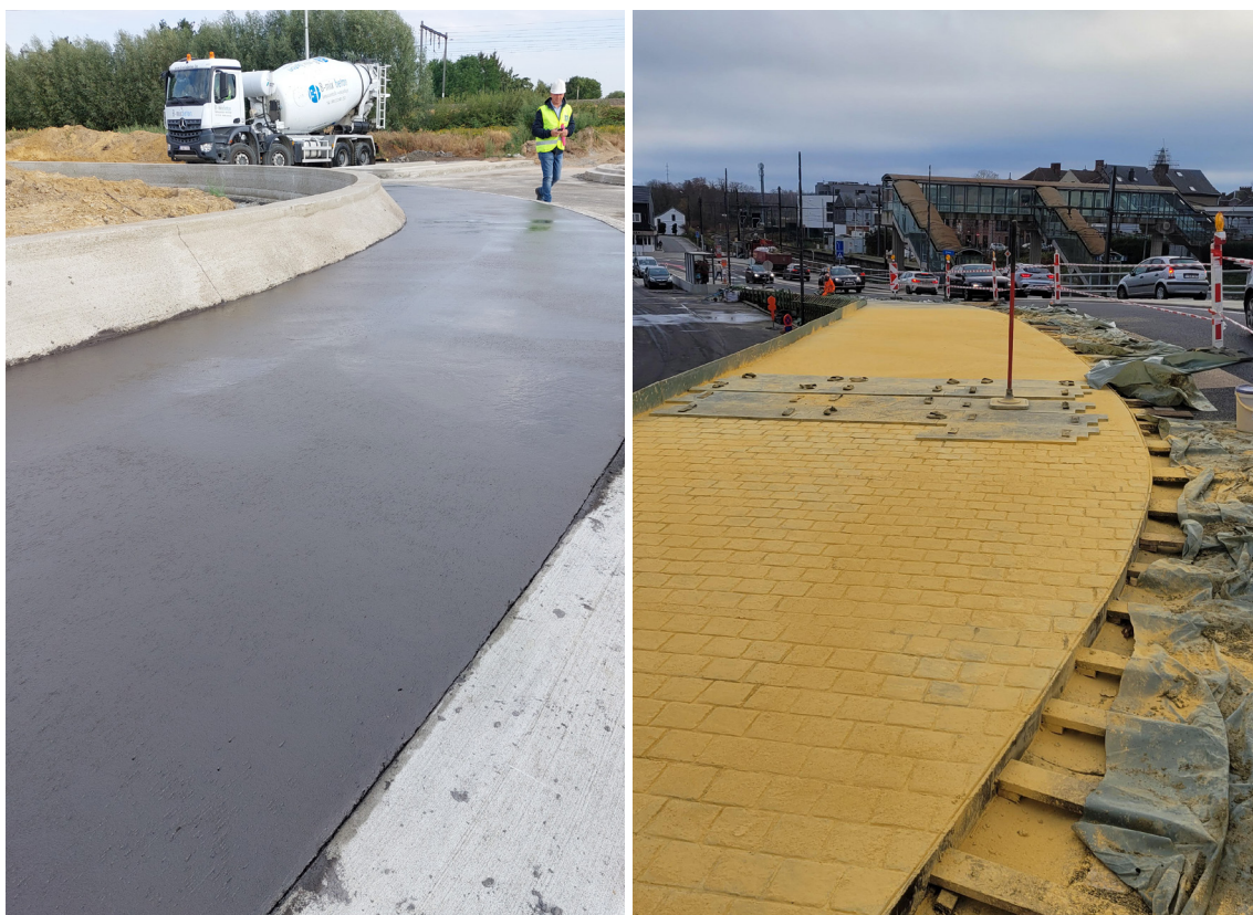
Figuur 4.3 – In de massa gekleurd beton voor toepassingen volgens systeem 2A: met 5% zwart pigment (links, ©OCW) en geel gekleurd (rechts, ©Colas Belgium).
