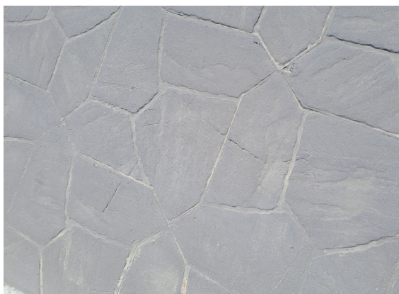
Figuur 6.1 – Visuele inspectie van een verharding in gefigureerd beton.
