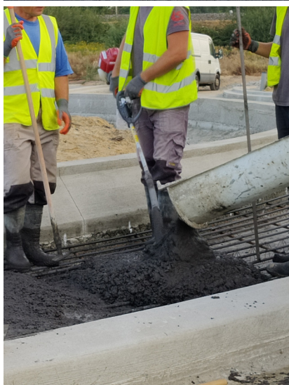
Figuur 4.1 – Manuele aanleg van gefigureerd beton op de rammelstrook van een rotonde. De verdichting gebeurt met behulp van trilnaalden.
