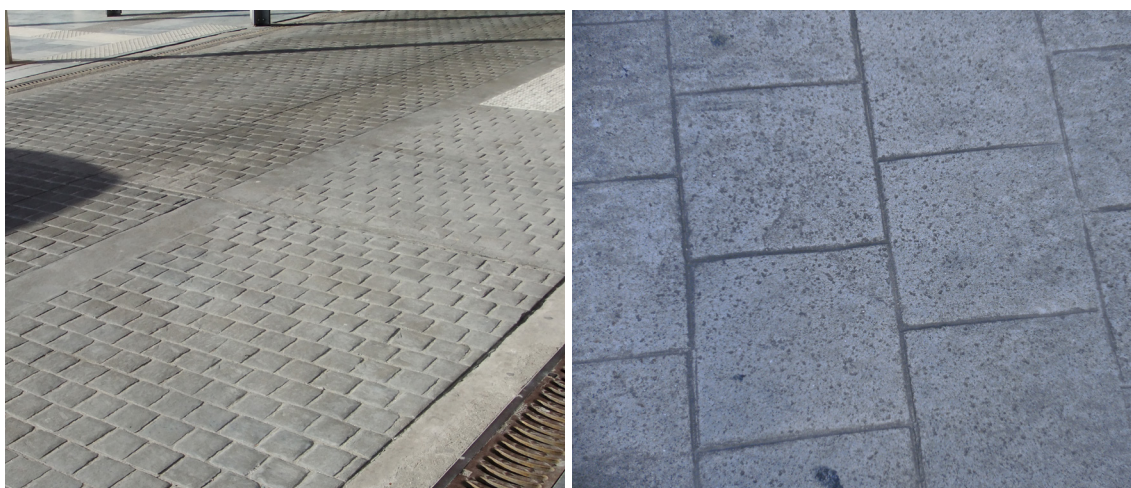
Figuur 4.6 – Diepere print met matten (links) in vergelijking met de rol (rechts) (©Febelcem).
