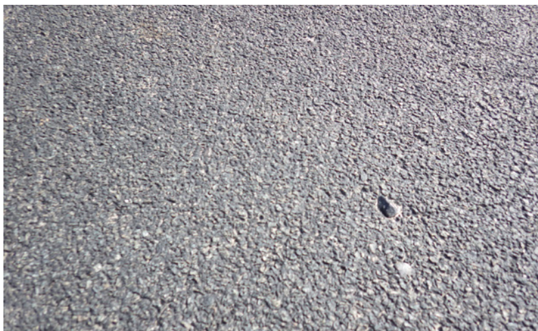
Figuur 2.21 – Dichtgereden groef, enkel de grotere steen is nog zichtbaar
