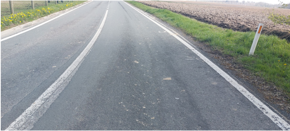
Figuur 2.8 – Voorbeeldfoto rafeling met ernstgraad 5_algehele rafeling en uitrukking in en tussen beide wielsporen
