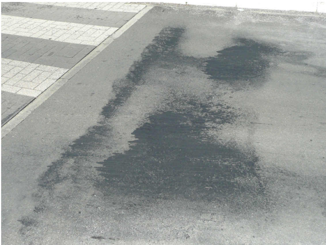
Figuur 2.19 – Ernstgraad 3 zweten – individuele stenen niet meer zichtbaar
