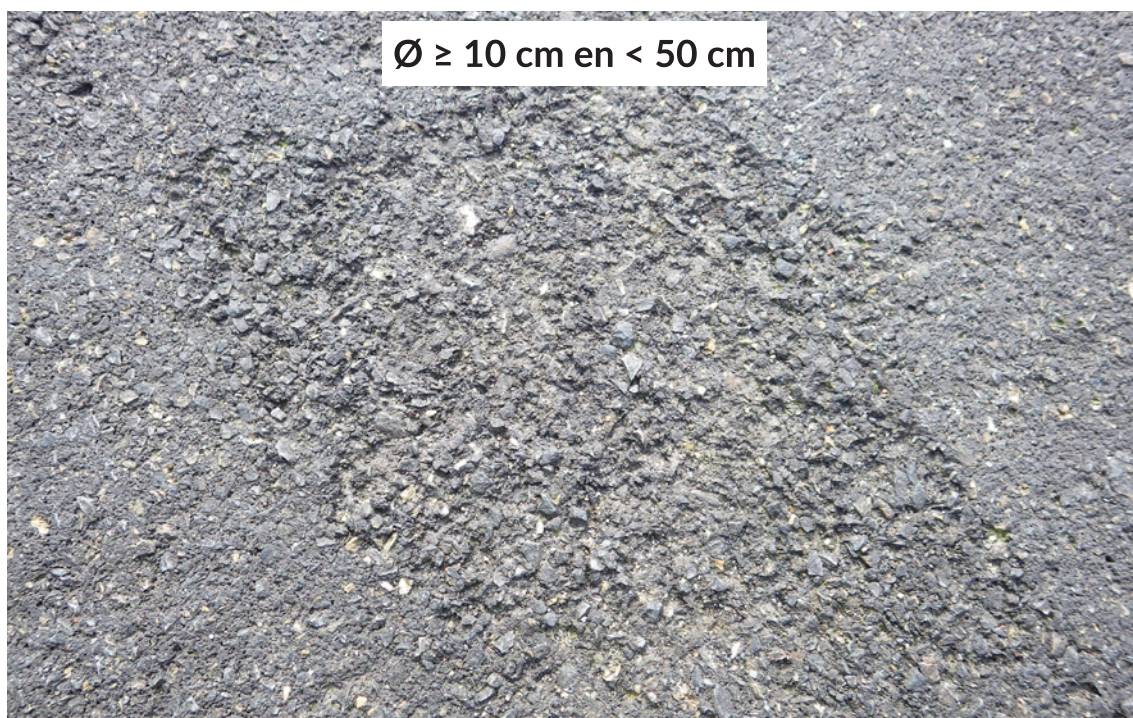
Figuur 2.7 – Voorbeeldfoto rafeling met ernstgraad 4_uitrukking fase 3
