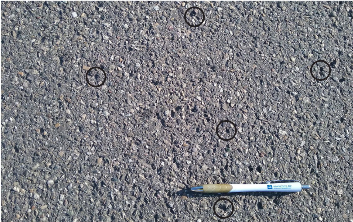
Figuur 2.4 – Voorbeeldfoto rafeling met ernstgraad 1_individueel steenverlies
