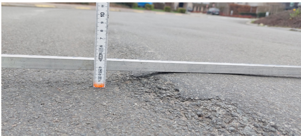
Figuur 2.24 – Bultvorming
