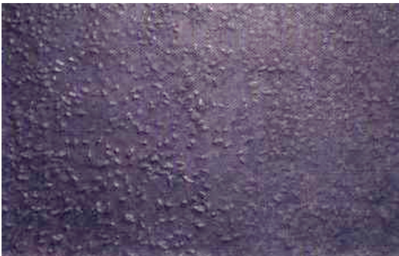
Figuur 2.18 – Ernstgraad 2 zweten – individuele stenen zichtbaar
