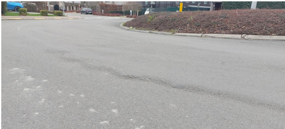
Figure 2.25 – Déformation due au glissement
