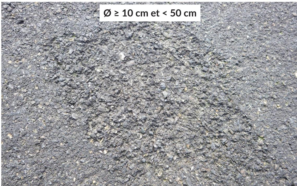
Figure 2.7 – Exemple de plumage avec un niveau de sévérité 4\_arrachement phase 3
