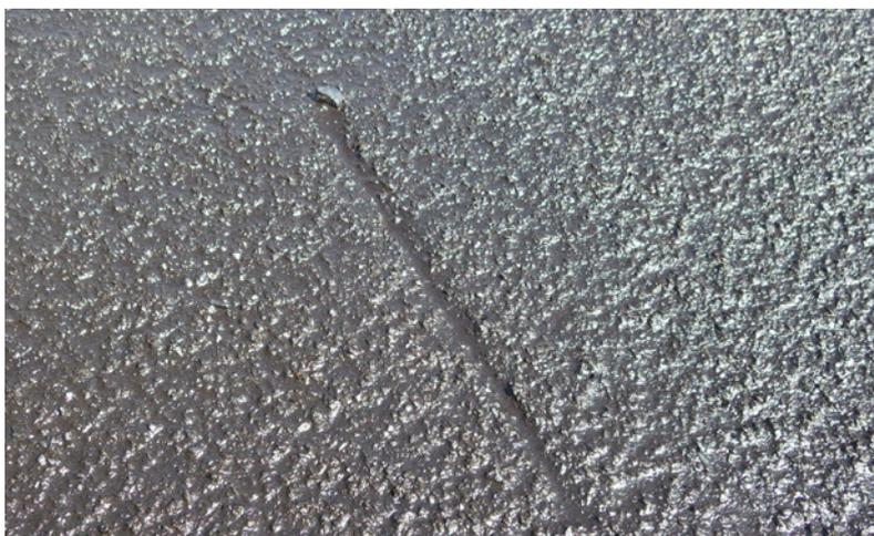
**Figure 2.20** – Rainure longitudinale – la cause (grosse pierre) est encore clairement visible
