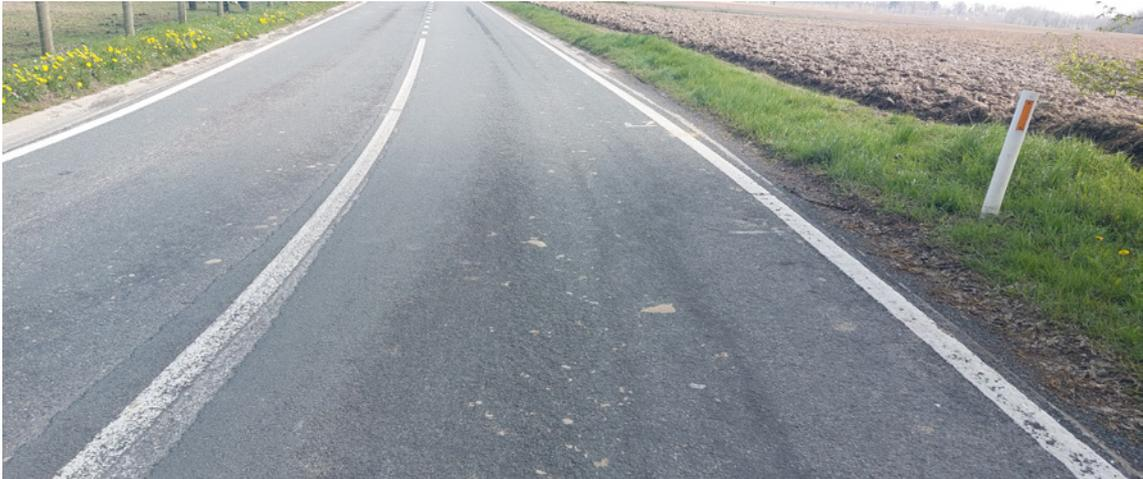
**Figure 2.8** – Exemple de plumage avec un niveau de sévérité 5\_plumage généralisé et arrachement dans et entre les deux frayées
