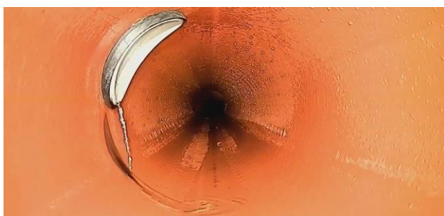
Foto 68 (Bron BRRC) Inlaat met zadelhulpstuk BCA-B
