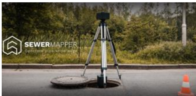
Foto 46 (Bron SewerMapper) Sewer Mapper-Toestel
