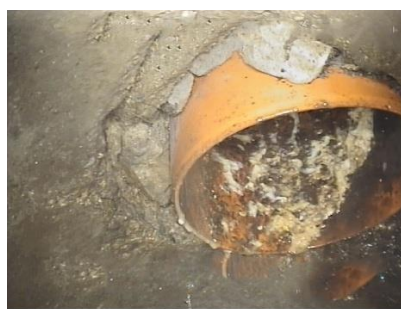
Foto 69 (Bron BRRC) Gebeitelde inlaat BCA-E
