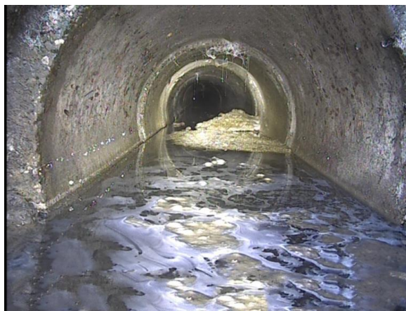
Foto 16 (Bron BRRC) Foto stationair genomen; bezonken afzetting + korstvorming >25%
