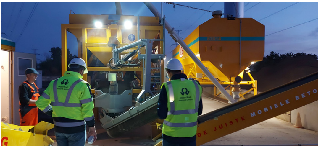
Figuur 4 – Proefproductiebatches met mobiele betoncentrale van ATF in aanwezigheid van OCW
