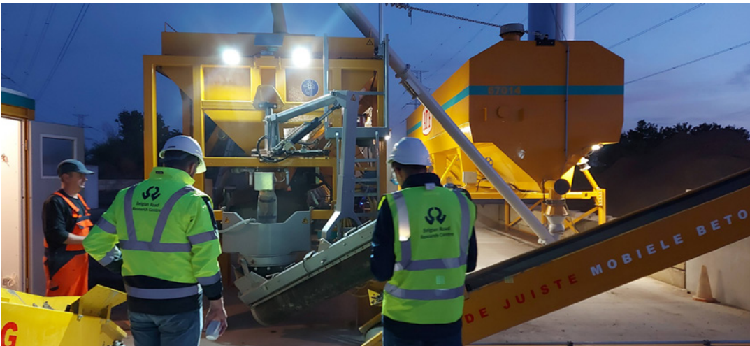
Figure 4 - Lots de production expérimentaux avec la centrale à béton mobile d'ATF en présence du CRR
