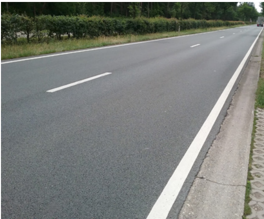
Figuur 11 – Proefvak F in zeer goede staat tien jaar na aanleg
