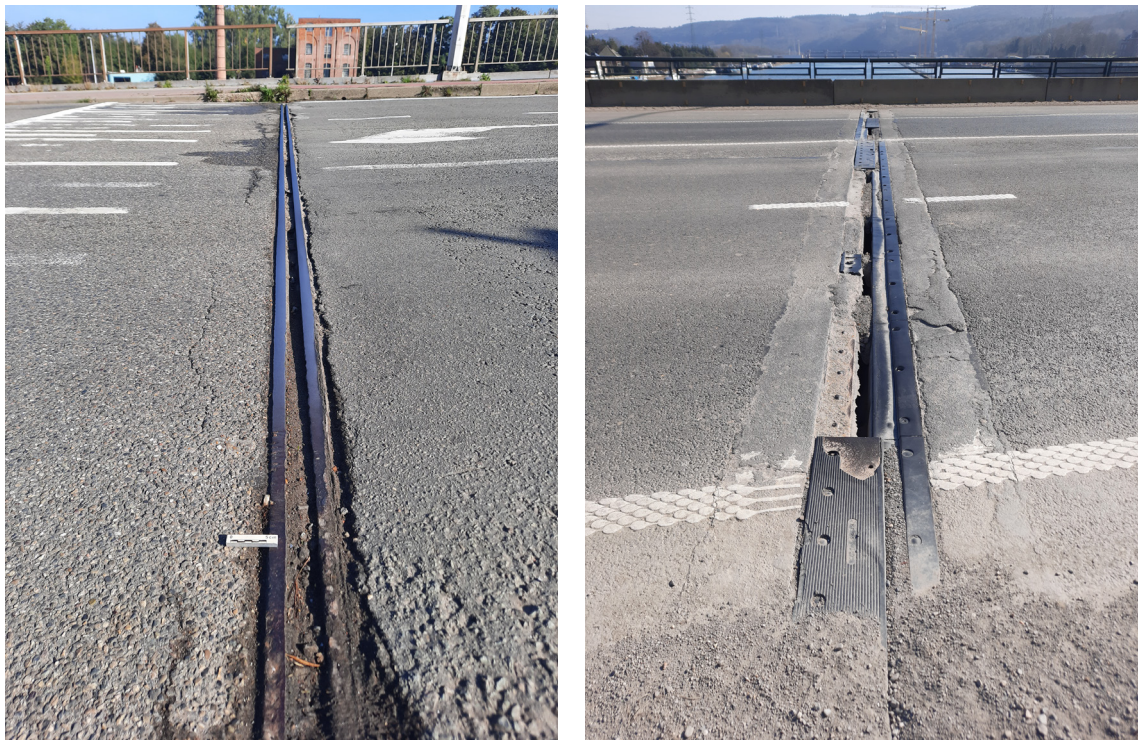
Figure 1.1 – L'état du joint peut avoir un impact négatif sur la production sonore
