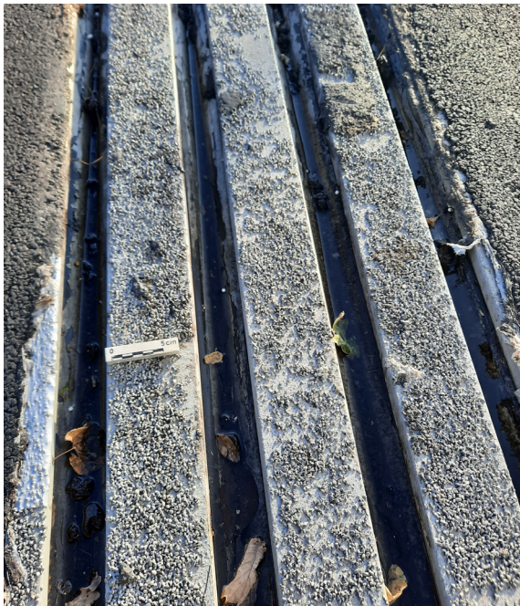
Figure 3.9 – Joints multiples métalliques traversant une piste cyclable sur un pont; la rugosité a été assurée en saupoudrant de la bauxite dans une couche d'époxy
