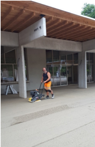
Figuur 6 – Verdichting met een trilplaat in de Plantentuin van Meise
