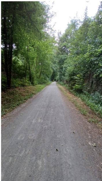
**Figure 9** – Chemin avec revêtement F<sub>4</sub> à Tervuren (juillet 2023, un an après la mise en œuvre)
