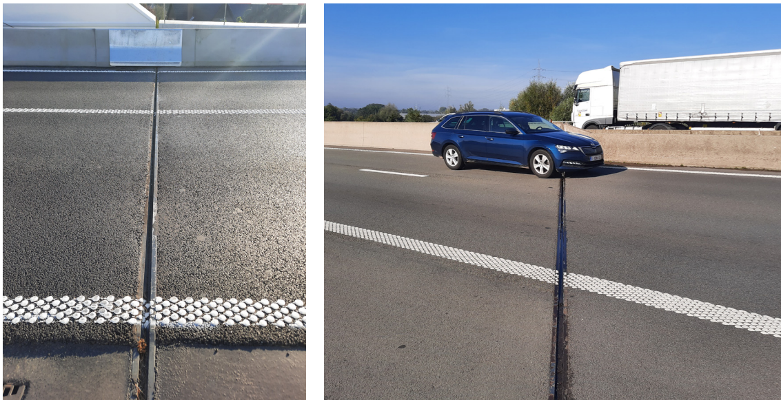
Figuur 3.5 – Enkelvoudige voegen: loodrecht op de rijrichting (links) en onder een hoek van 60° ten opzichte van de rijrichting (rechts). Bij eenzelfde voegbreedte en inbouwkwiteit is deze laatste 2,1 dB stiller dan de eerste
