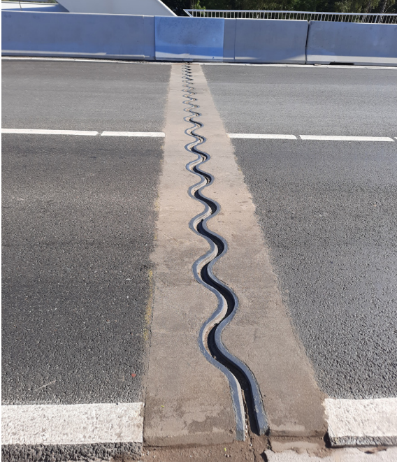
Figuur 3.11 – Sinusoïdale voeg
