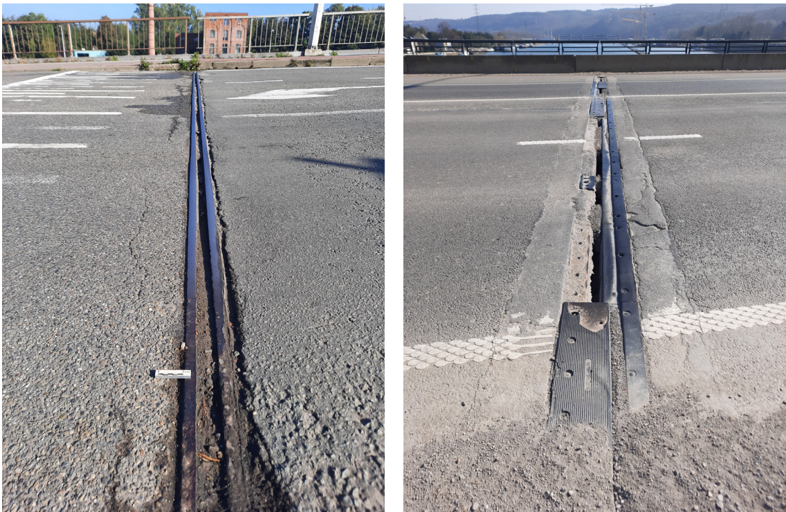
Figuur 1.1 – De staat van de voeg kan een negatieve impact hebben op de lawaaiproductie
