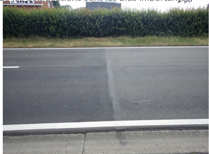
Figure 10 – Transition de la planche d'essais A à la B avec plumage sévère dans les deux mélanges
