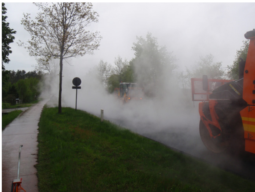
Figure 7 – Pluie pendant la mise en œuvre de la planche d'essais B sur la N19
