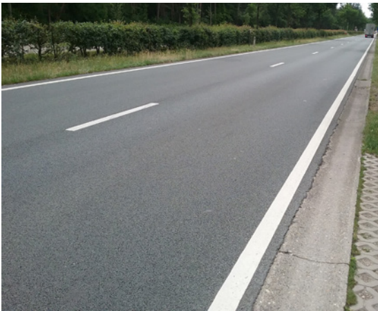
Figure 11 - Planche d'essais F en très bon état dix ans après sa mise en œuvre
