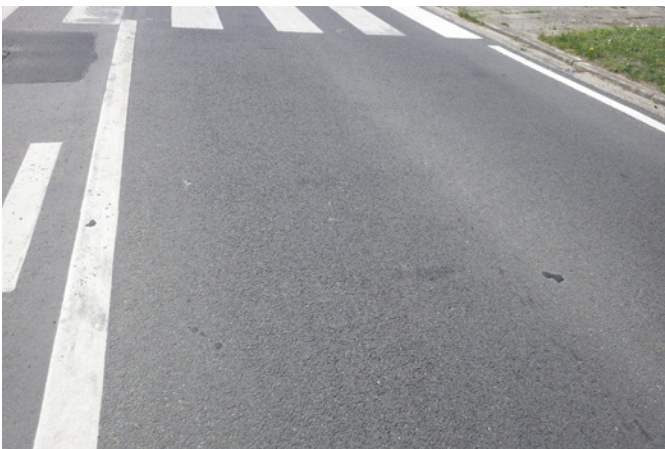
Figure 12 - Planche d'essais O à Wilrijk présentant un plumage important après un an
