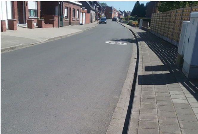
Figure 14 - Planche d'essais P à Zandvliet ne présentant aucun plumage après six ans
