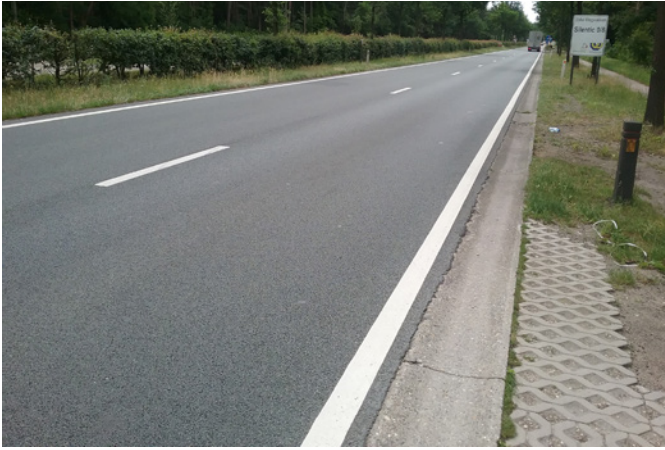
Figuur 11 – Proefvak F in zeer goede staat tien jaar na aanleg
