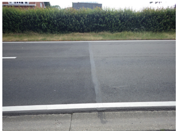
Figuur 10 – Overgang proefvak A naar B met ernstige rafeling in beide mengsels
