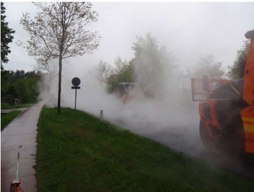
Figuur 7 – Regen tijdens aanleg proefvak B op N19
