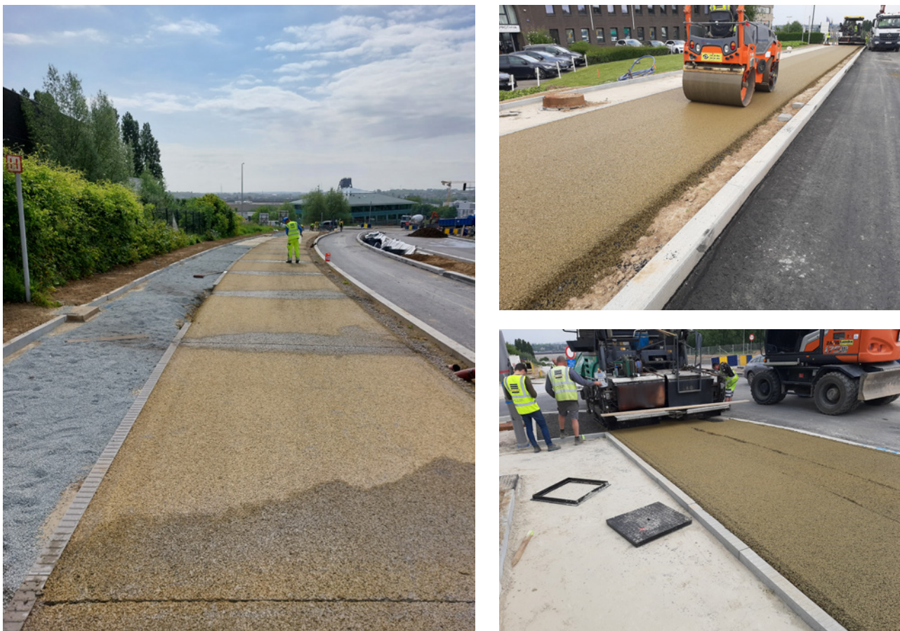
Figuur 15 – De meest recent gemonitorde uitvoering van drainerend beton op een fietspad te Neder-Over-Heembeek, met toepassing van een asfaltspreidmachine gevolgd door afwalsen
