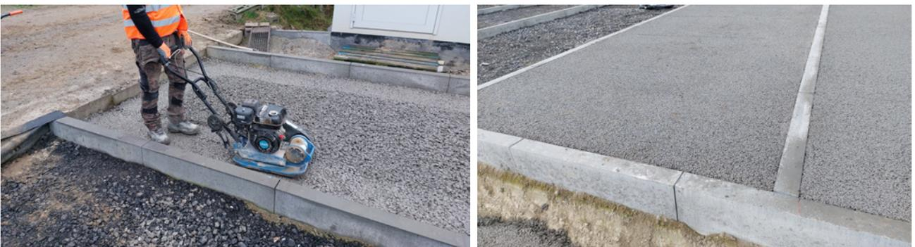
**Figure 1** – Mise en oeuvre récente de compositions de béton drainant sur des planches d'essais à Sint-Niklaas, en collaboration avec Aquafin et Holcim
