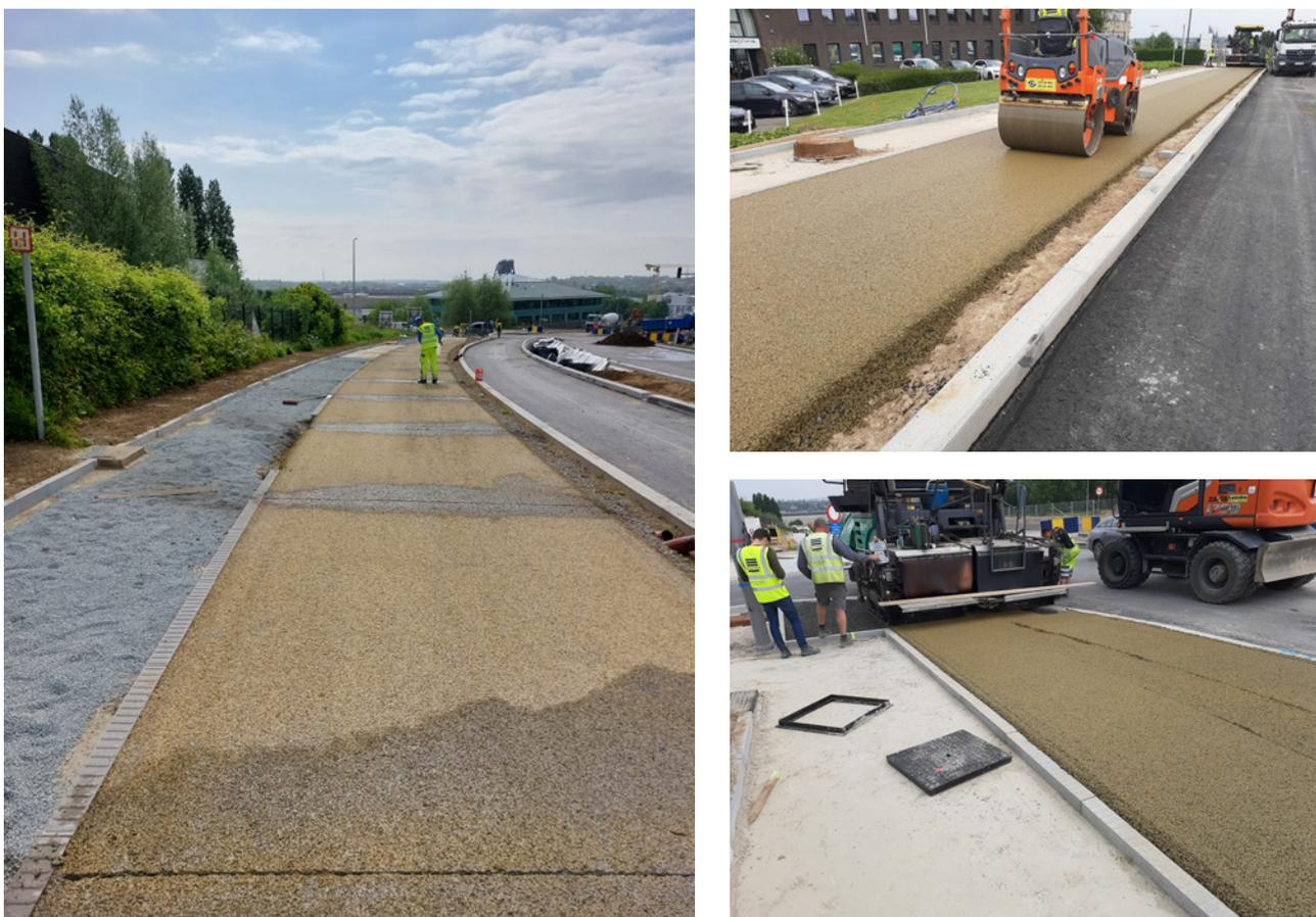
**Figure 15** – Mise en oeuvre récente de béton drainant sur une piste cyclable à Neder-Over-Heembeek, à l'aide d'un finisseur, puis d'un compacteur à rouleau
