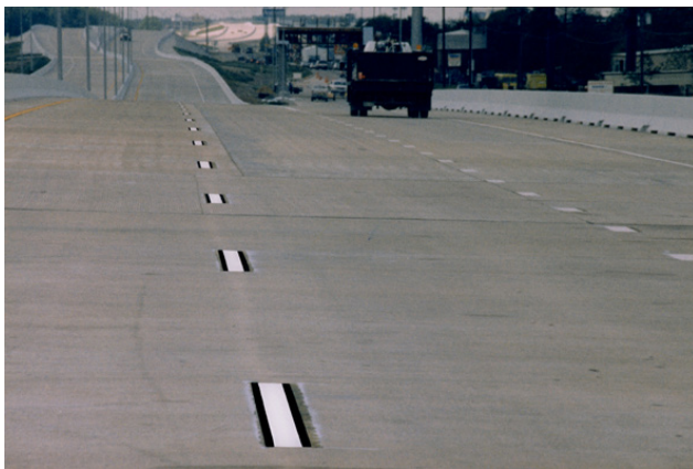
Figure 4 - Le contraste entre le revêtement et les marquages routiers pourrait prendre une plus grande importance à l'avenir
