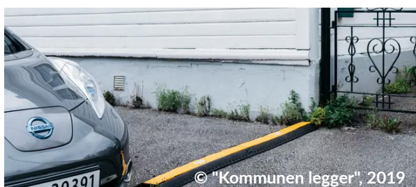
Figure 2 – Câble traversant le trottoir (Norvège)
