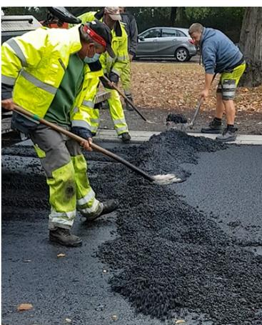
Figure 2 – Mise en œuvre manuelle d'un mélange bitumineux
