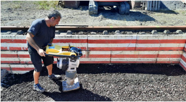
Figuur 10 – Verdichting met trilhamer (links) en trilplaat (rechts)
