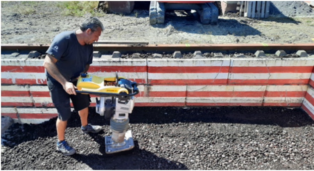
Figure 10 – Compactage à l'aide d'un marteau vibrant (à gauche) et d'une plaque vibrante (à droite)
