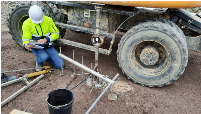
Figure 14 – Réalisation de mélanges terre-pierres sur le chantier – essais à la plaque statique
