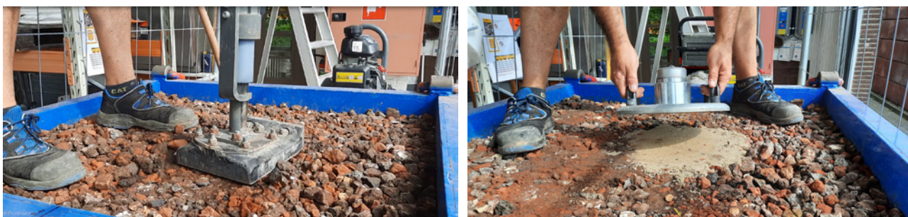
Figure 8 – Compactage et essai à la plaque dynamique (0/40 B3bis) – deuxième essai
