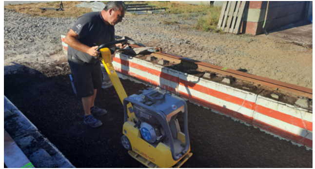
Figure 10 – Compactage à l'aide d'un marteau vibrant (à gauche) et d'une plaque vibrante (à droite)
