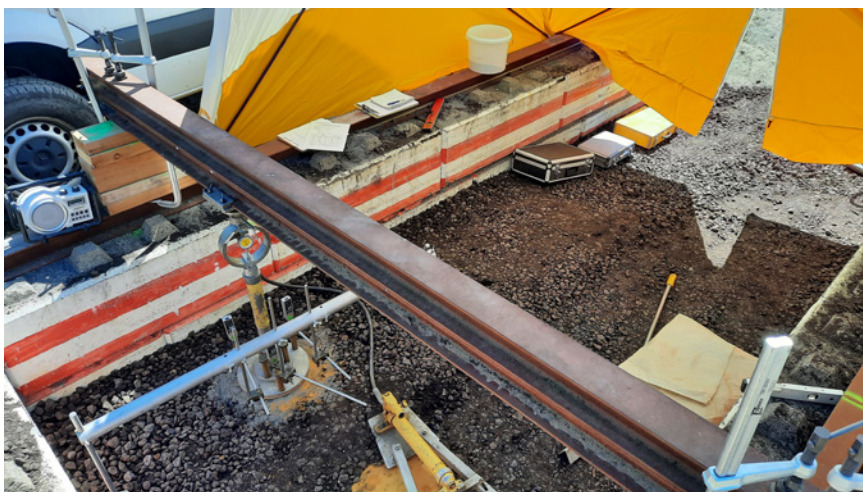
Figure 12 – Mesure avec l'essai à la plaque statique sur le matériau B1bis
