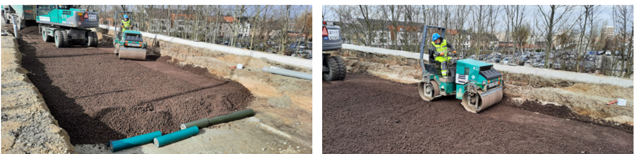
Figure 13 – Réalisation de mélanges terre-pierres sur le chantier
