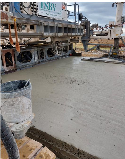
Figuur 7 - "Scheuren" van het oppervlak, waargenomen wanneer een hoge snelheid wordt gecombineerd met een lage trillingsfrequentie
