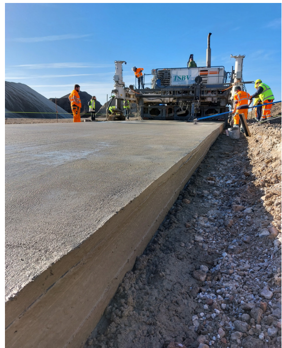
Figuur 1 – Eerste proefvak van het Monocrete-project in Bierset
