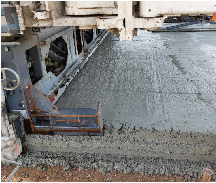
Figuur 6 - Onregelmatigheden in het oppervlak, waargenomen bij gebruik van een lage snelheid in combinatie met een hoge trillingsfrequentie
