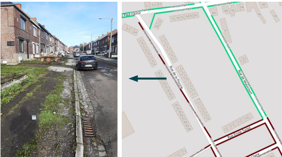
Figuur 5 – Niet gemeten voetgangersruimte bij gebrek aan harde materialen volgens de definitie van trottoir in de wegcode
