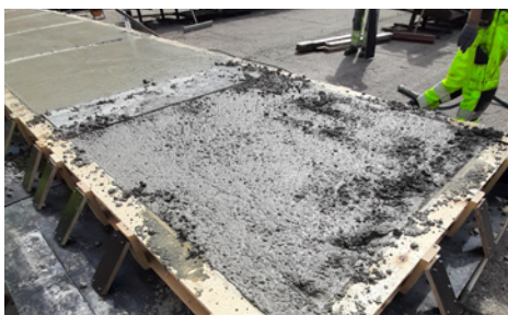
Figuur 9 – Aanmaak van “rubberbetonplaten” bij de betoncentrale van Colas te Zolder, die gebruikt zullen worden voor de fysieke impactproeven met een personenvoertuig
