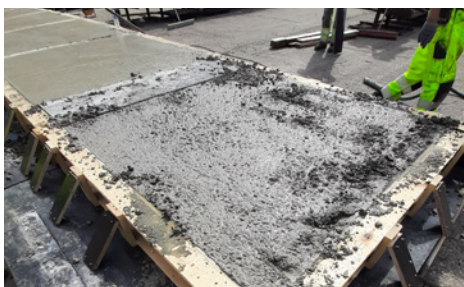
Figure 9 – Création de «dalles en béton de caoutchouc» à la centrale à béton de Colas à Zolder, qui seront utilisées pour les essais d'impact physiques avec une voiture particulière
