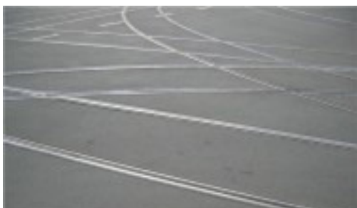
Gietasfalt tussen tramrails
