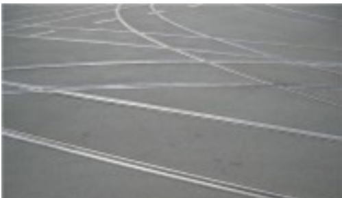
Asphalte coulé entre les rails de tram
