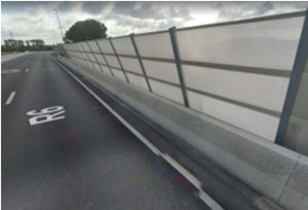
Écrans antibruit translucides absorbants sur le R6 à Malines
