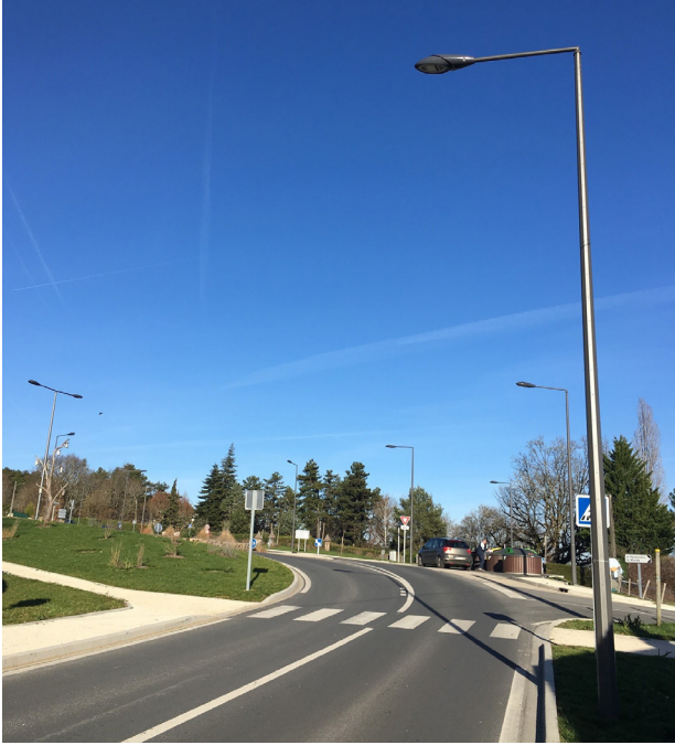
Installatie ZIPpole in Trélissac (Frankrijk)
