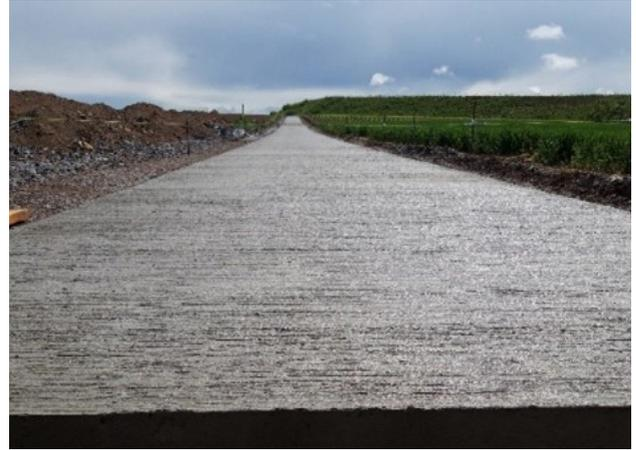
Revêtement en béton avec béton recyclé (projet Ridias, Gembloux)
