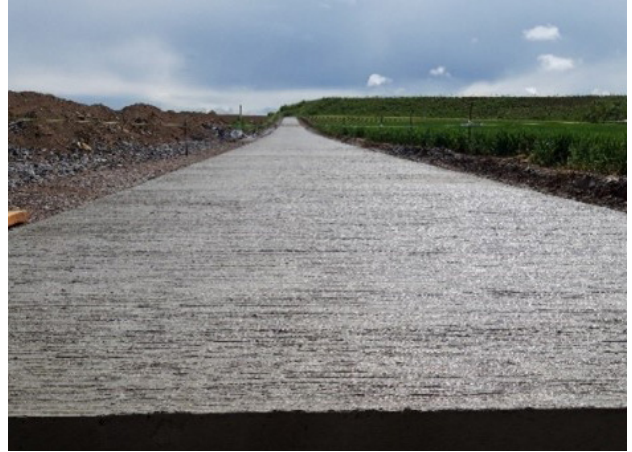
Betonverharding met gerecycleerd beton (Ri-dias project, Gembloux)
